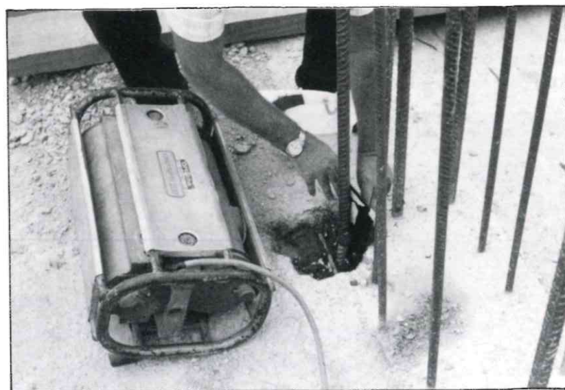
PALACIO DE DEPORTES. Radiografía para control de soldadura.
