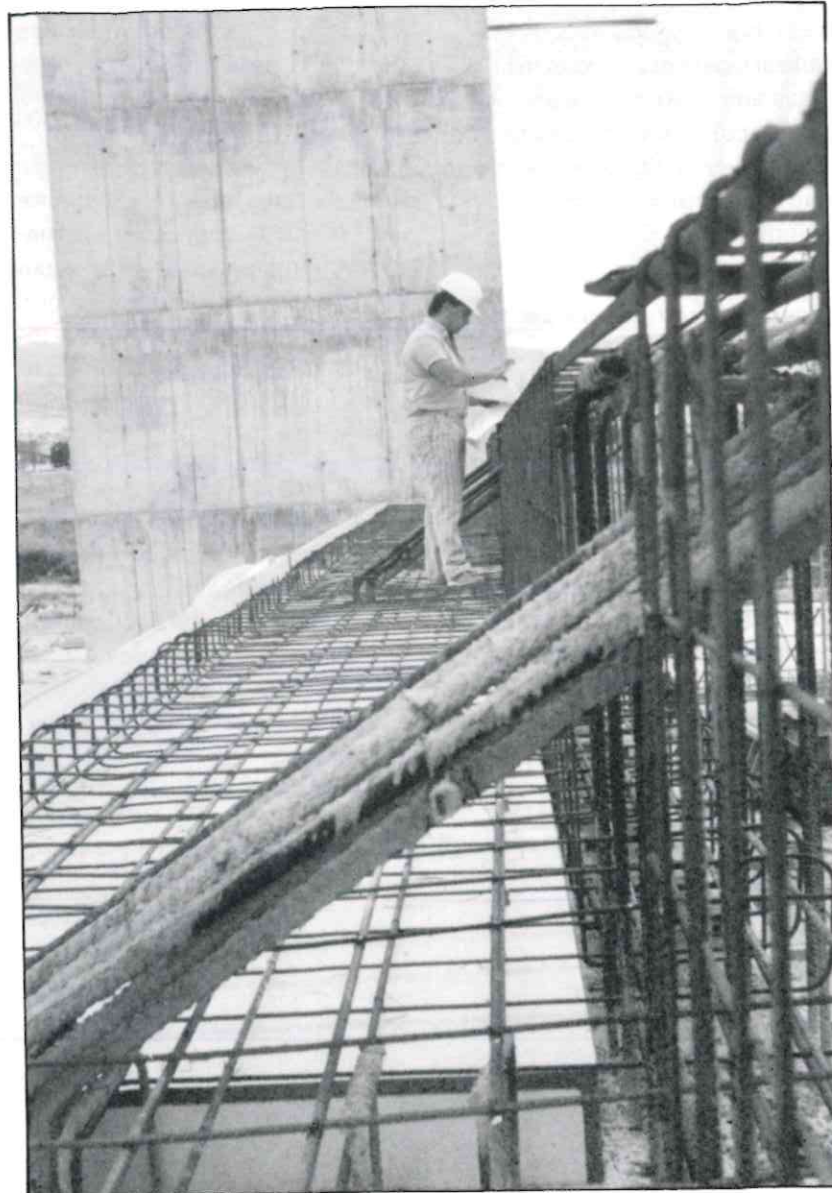
PALACIO DE DEPORTES. Comprobación Ferralla.
