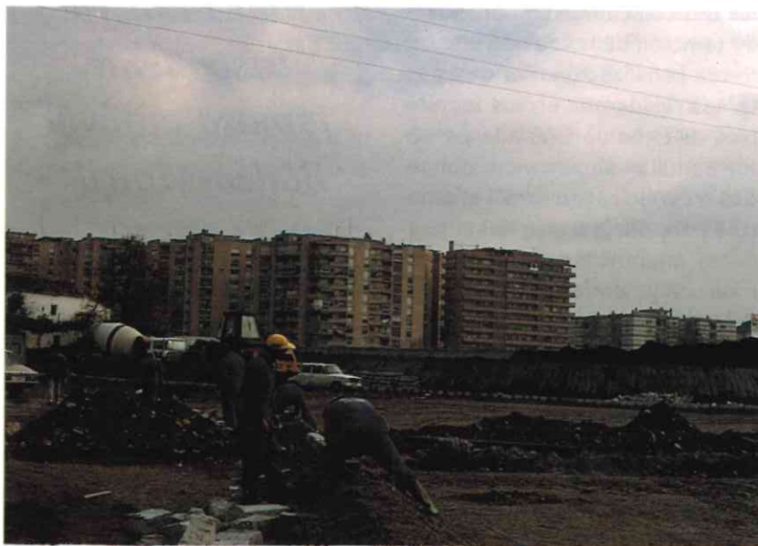
Los trabajos se han acelerado últimamente, tras algún tiempo de retraso.
