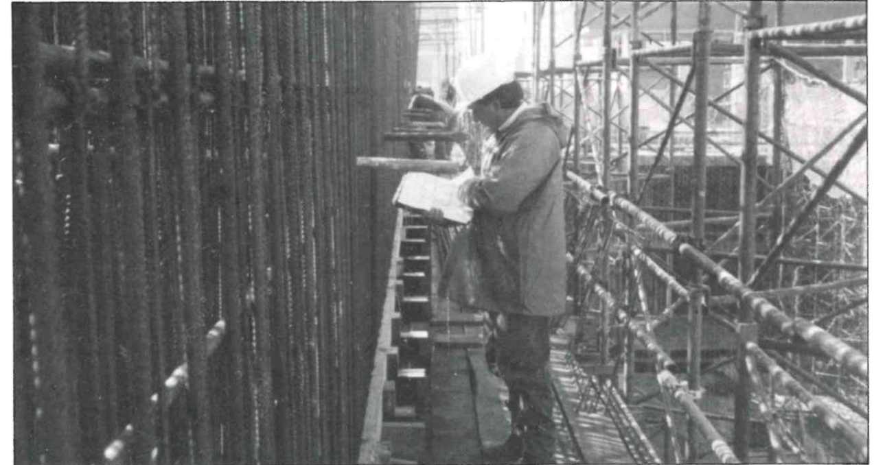
P. de C. Control ferralla viga "A".
