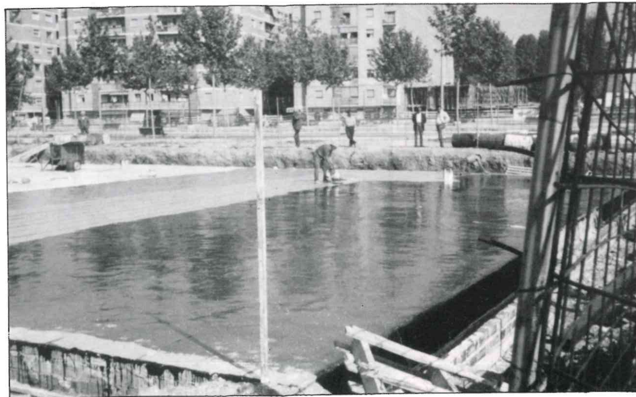
P. de C. Control de Impermeabilización de parking.
