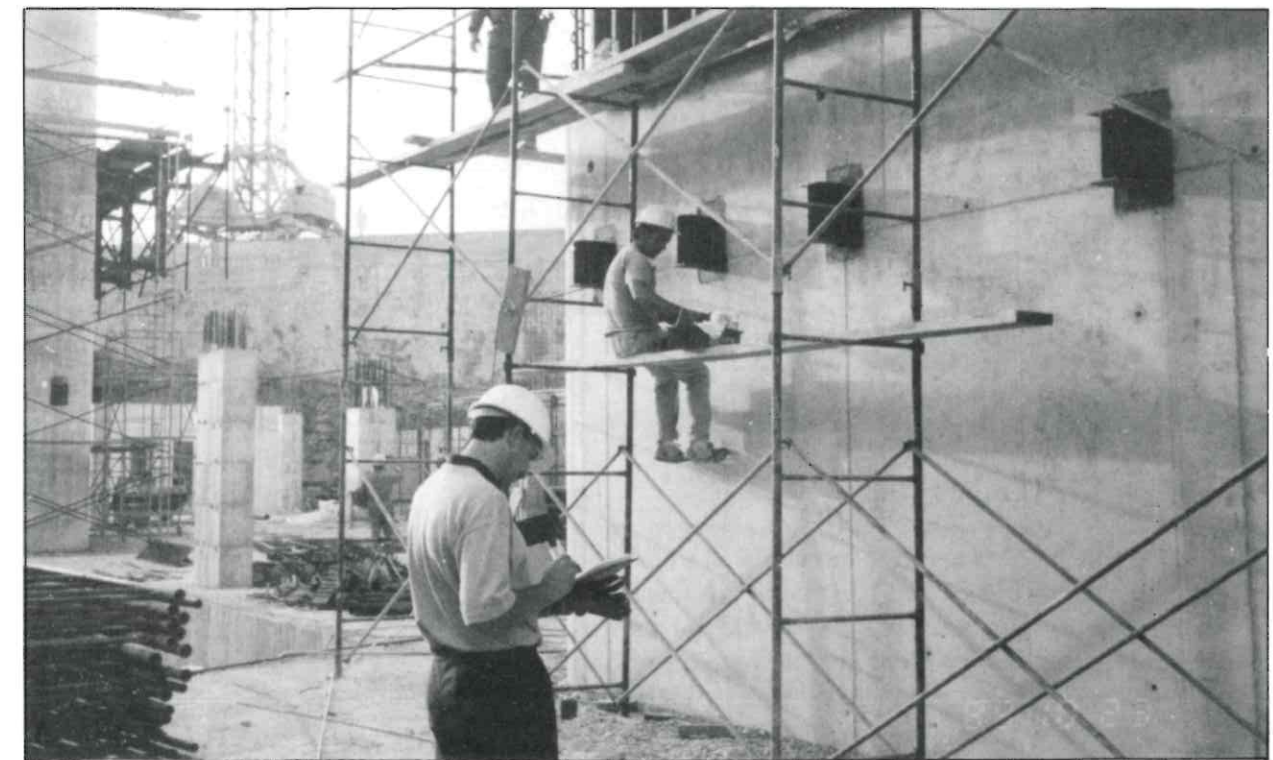
P. de C. Control de soldaduras con líquidos penetrantes.
