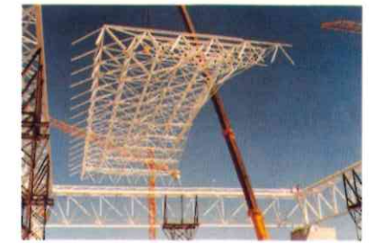
Montaje de la malla especial (derecha)
