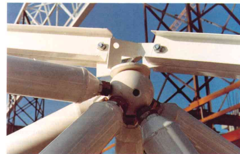
Detalle del nudo superior de la malla (abajo)
