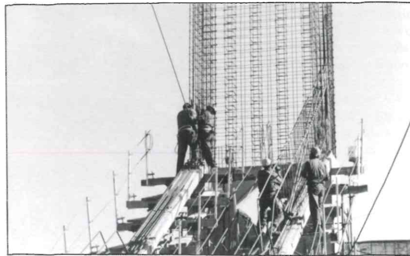
Pórticos de gradas (arriba)
