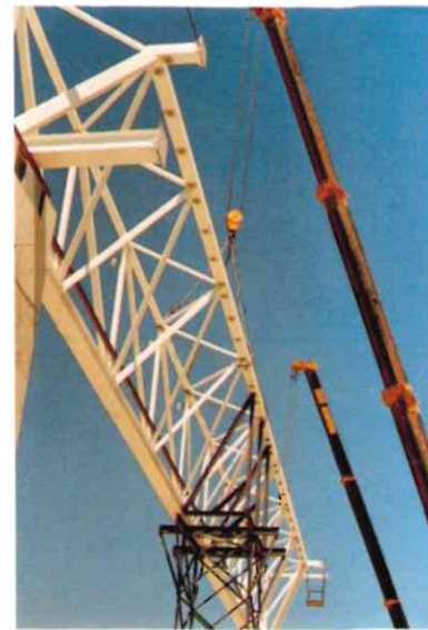
Montaje de las jácenas
