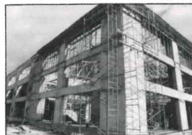
Pórticos de fachada (izquierda)
