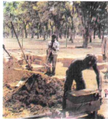
Fabricación semi-industrial de adobes. Foto realizada en México por Jacques Evrard. (Des architectures de terre).
