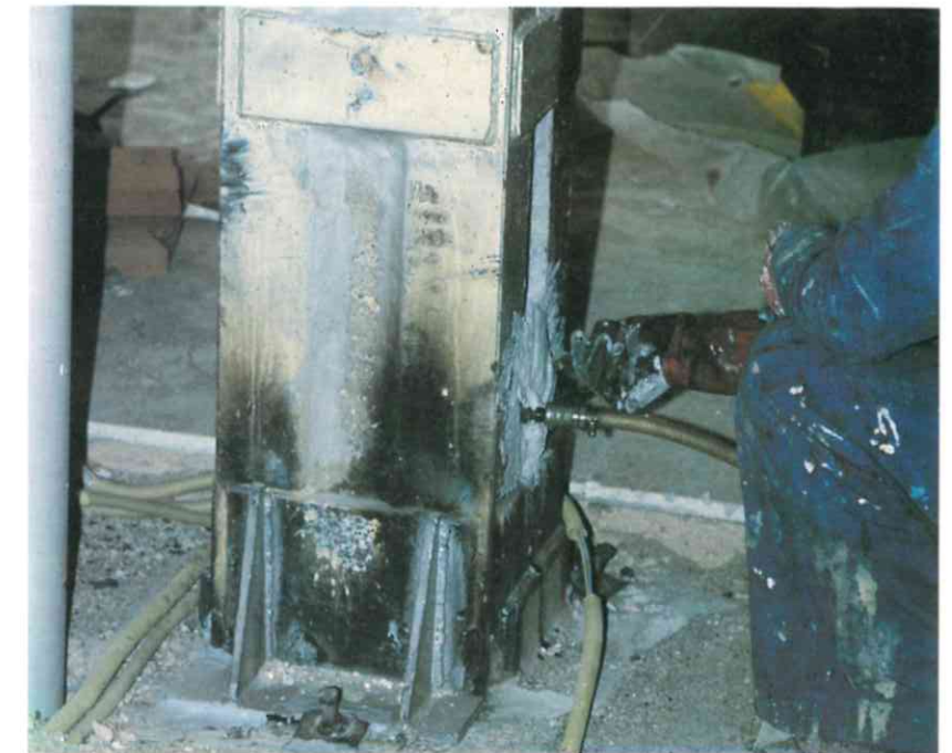
Detalle de la inyección de una formulación epoxidica, en el refuerzo de un pilar de hormigón
