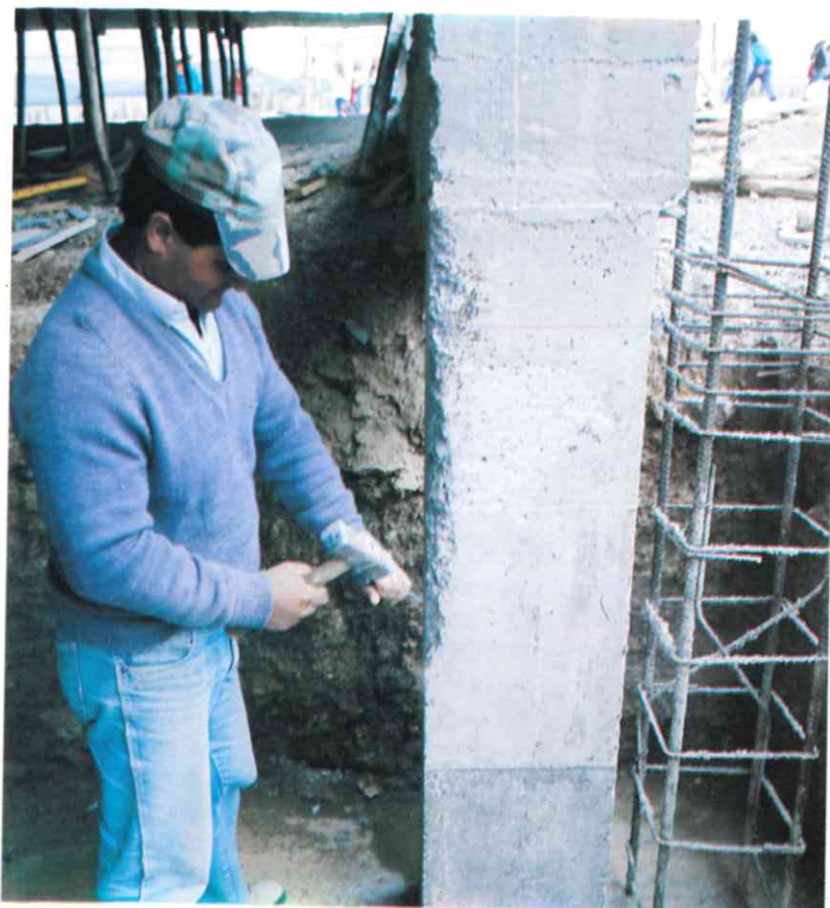
Matado de esquinas. (Eliminación de aristas vivas).
