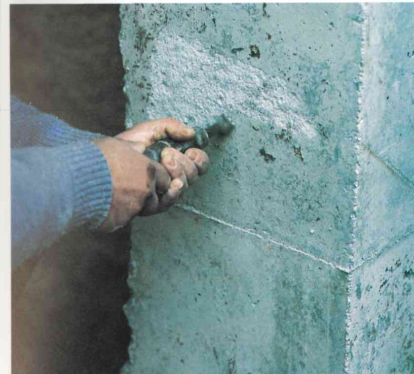
Eliminación de la lechada superficial mediante abujardado neumático
