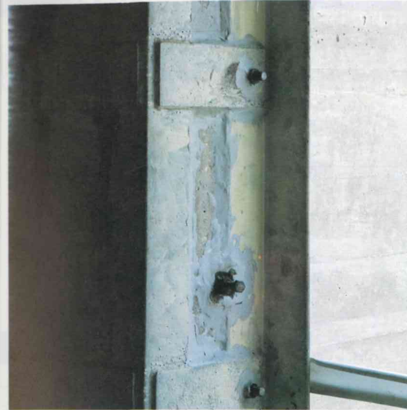
Encamisado discontinuo, sellado, y dispuestas las boquillas para inyección de material intermedio.
