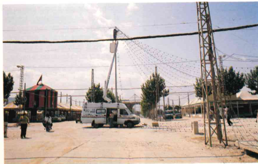
Puesta a punto del tendido eléctrico.
