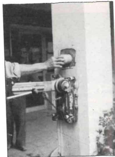
Retirada de la probeta testigo, una vez finalizado el corte de la probeta.
