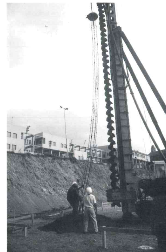
3. Introducción de armaduras, tras el hormigonado de un pilote in situ.
