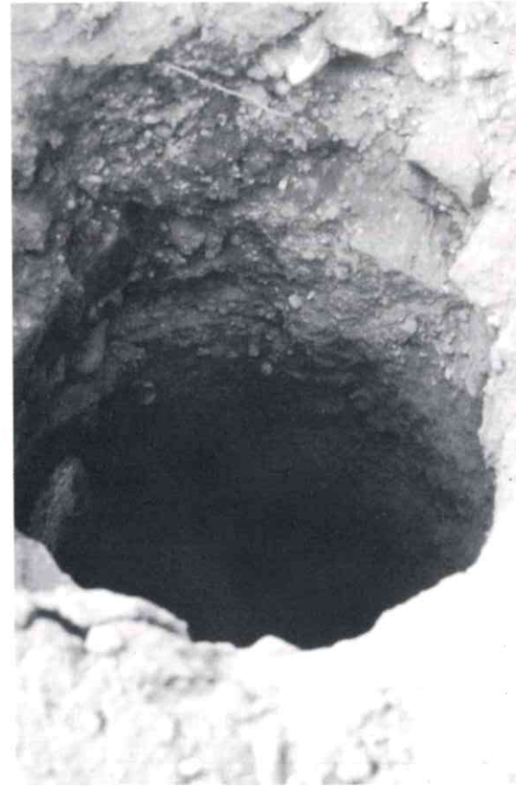
2. Perforación para la ejecución de un pilote in situ (pilote de extracción).
