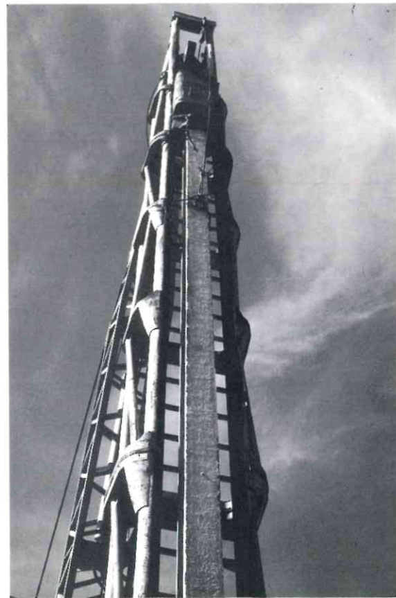
1. Pilote prefabricado dispuesto para su hinca (pilote de desplazamiento).
