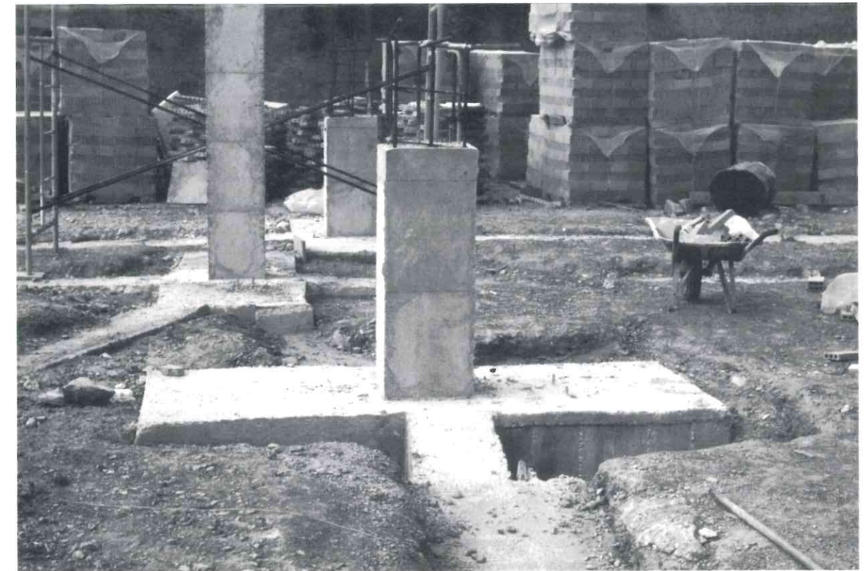
5. Encepado terminado y arranque de soporte.
