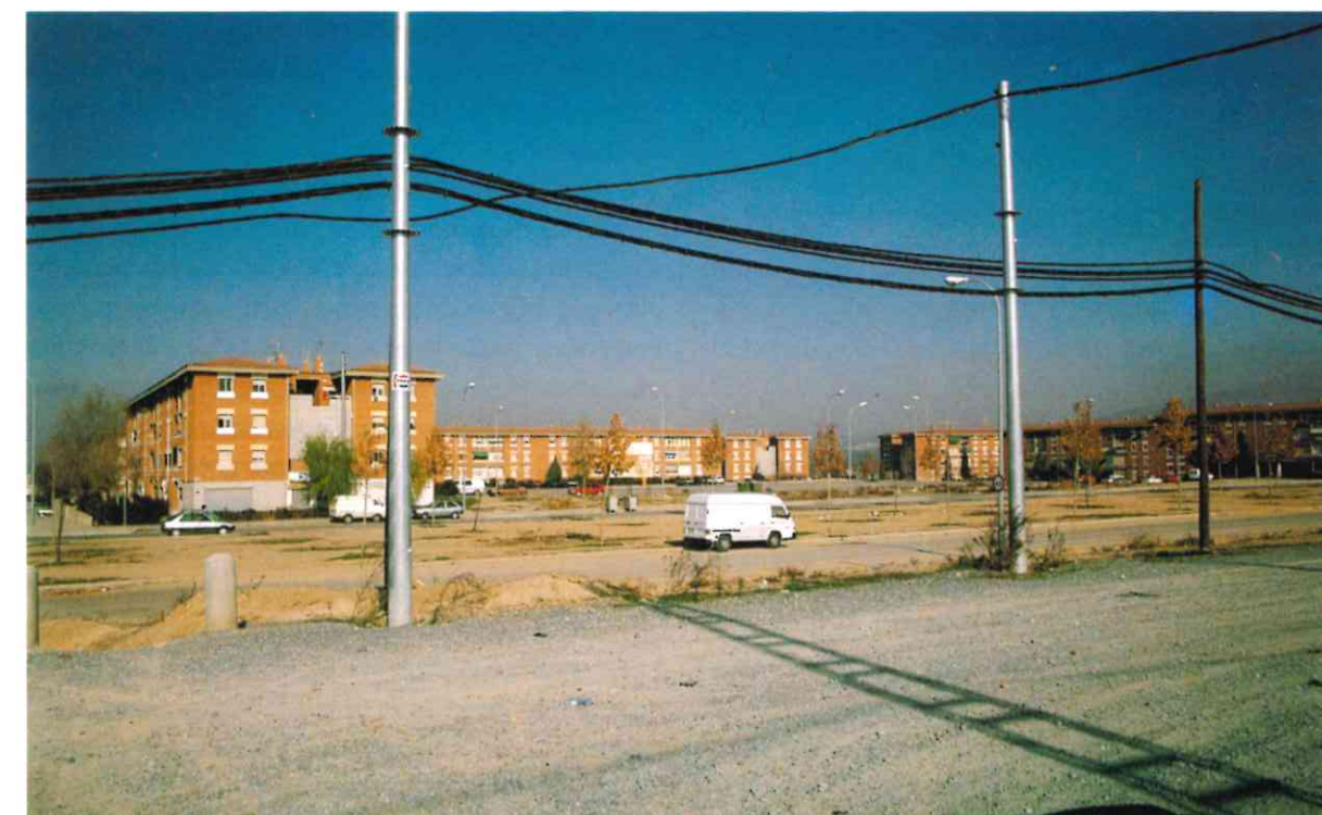
Almanjáyar es una de las zonas de la ciudad en que más edificios se están construyendo
