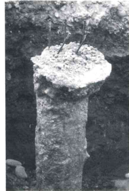
7. Fuste de pilote in situ, al que se le han extraído las tierras circundantes.
