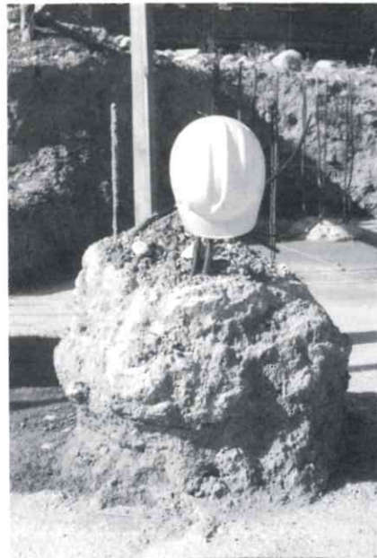
6. Pilote listo para un descabezado.
