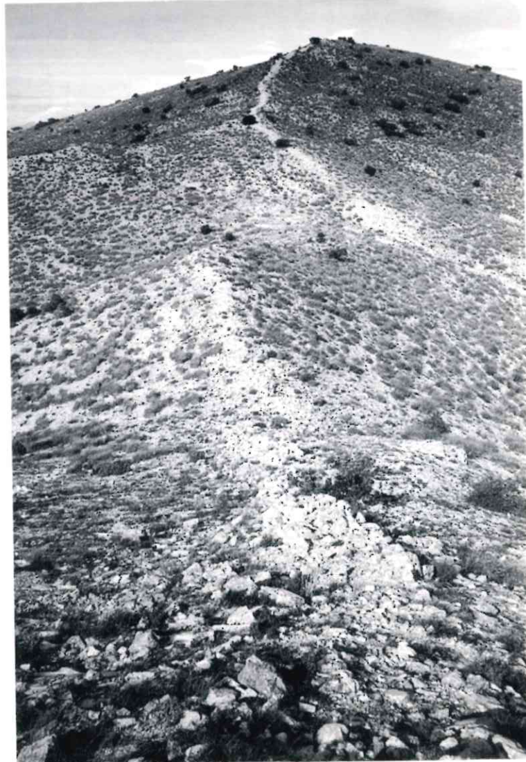
Vista general de parte de la muralla.
