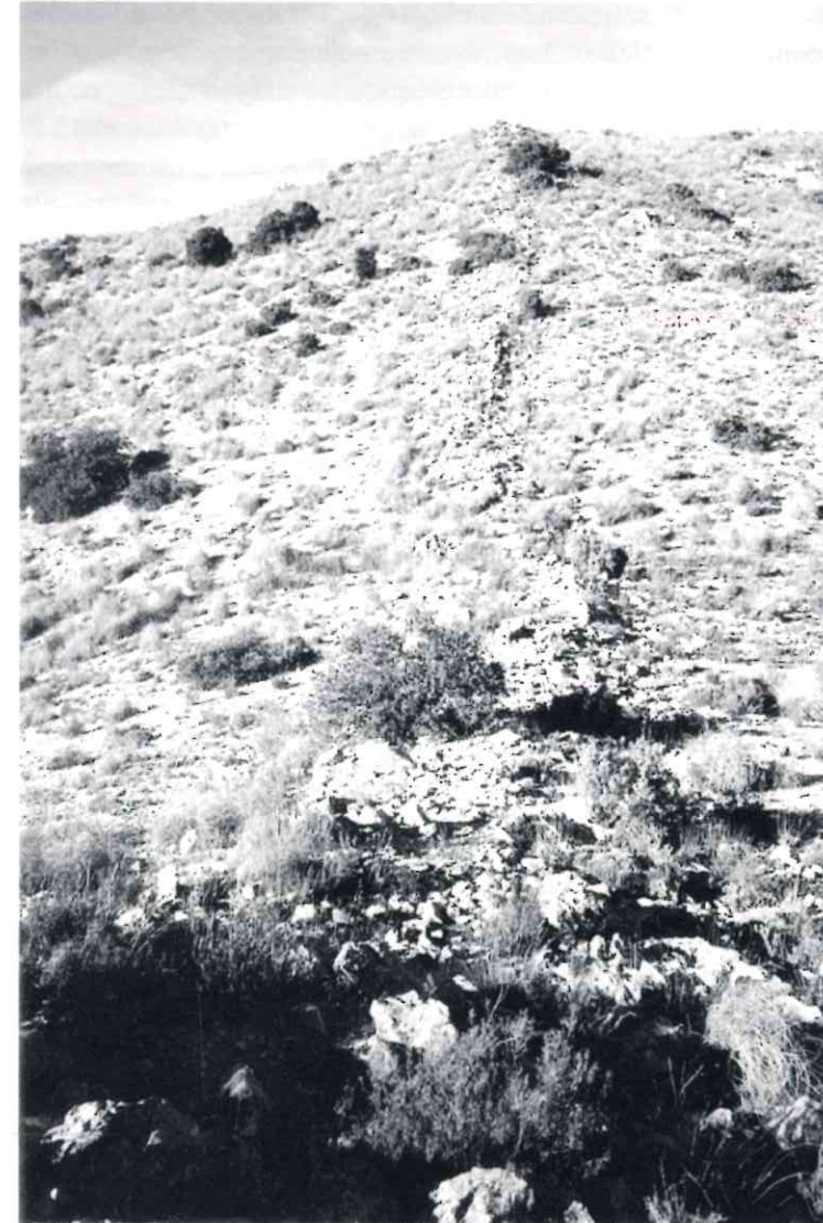
Vista de la muralla en la que se aprecia su estado actual.
