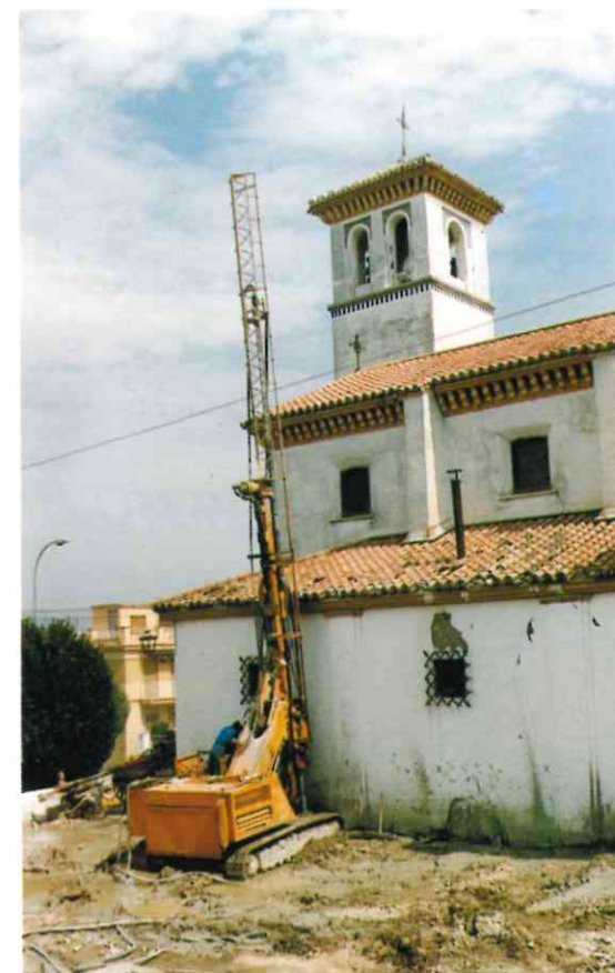
Realce con columnas de Jet-Grouting tipo 2B, de la Iglesia de Lachar (Granada).
