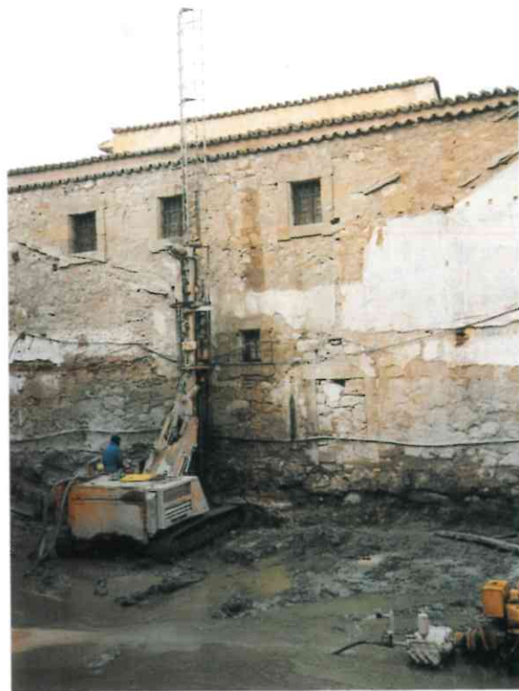
Pantalla impermeable con columnas de Jet-Grouting, con micropilotes, para protección de sótanos, de edificio depósito del archivo histórico de Salamanca.
