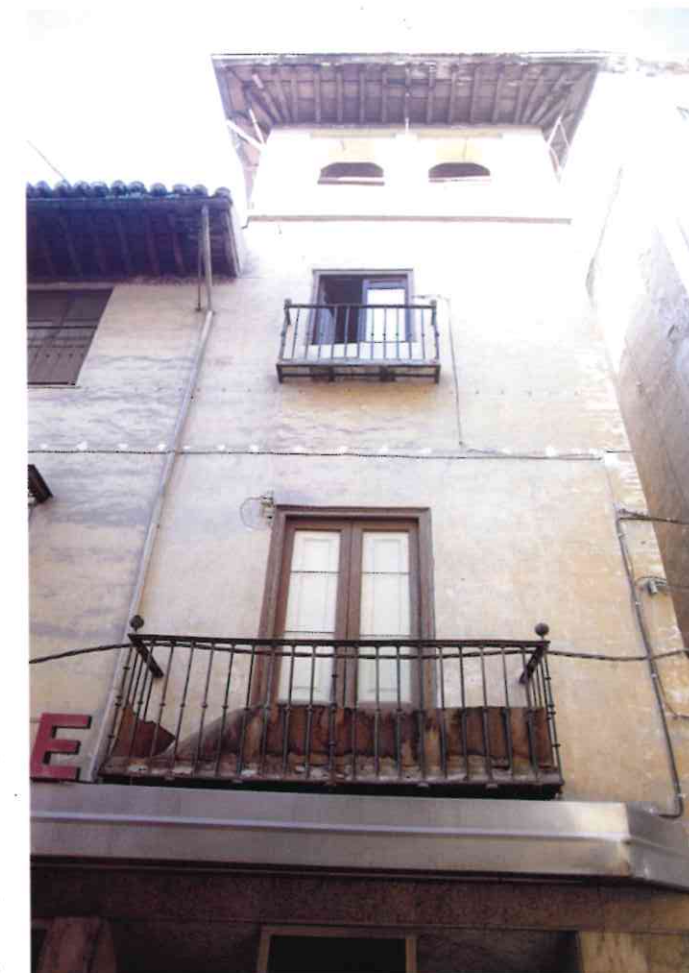
Fachada de la nueva sede colegial en la calle San Matías
