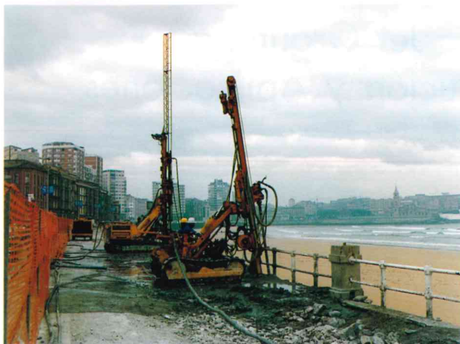
Cimentación con columnas de Jet-Groutin, de 1 m. de diámetro, del muro de contención del Paseo Marítimo de Gijón (Asturias)
