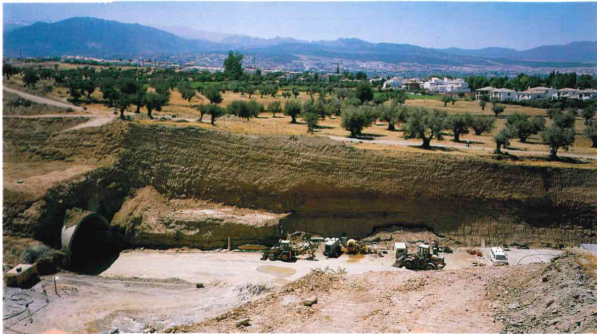
Obras de los nuevos accesos a la Sierra
