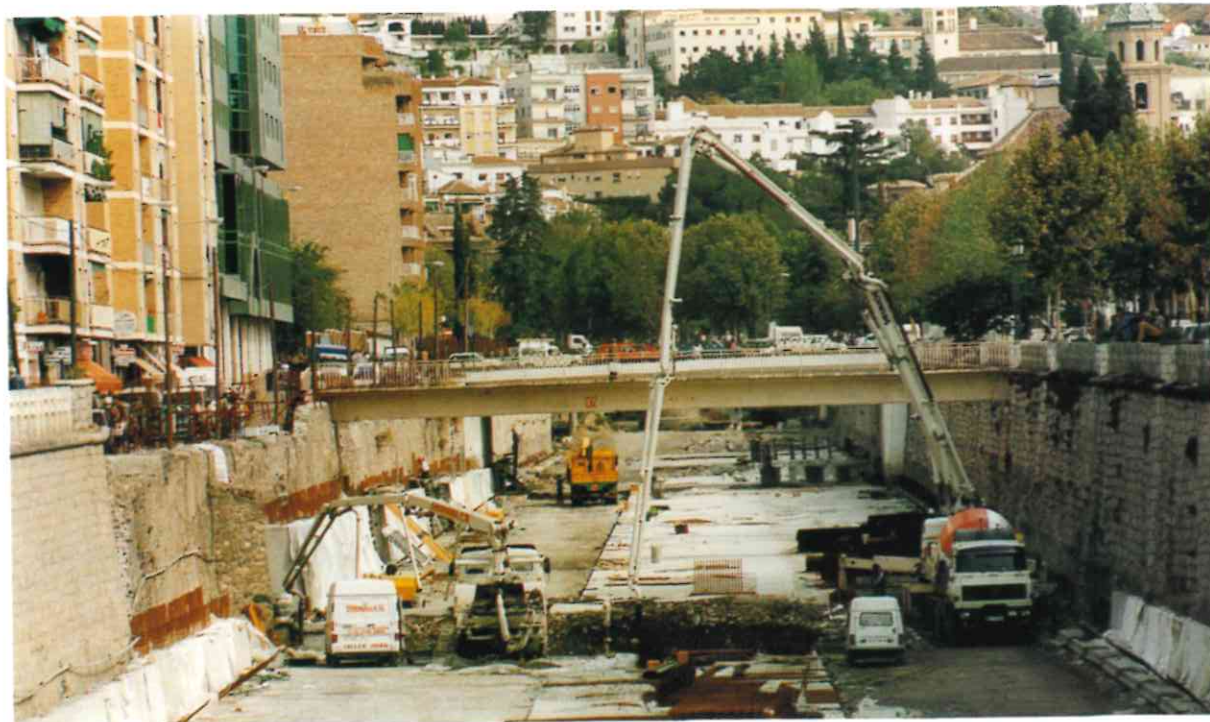
Obras en el cauce del río Genil
