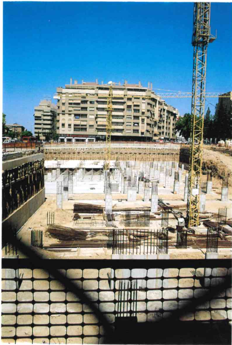
Las obras se han reanudado a marchas forzadas
