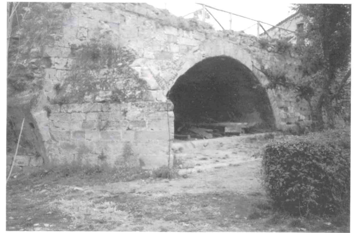
Ruinas del puente de Belorado sobre el río Tirón conocido como Puente del Canto.
