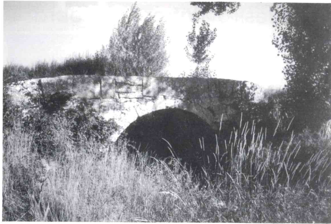
Puente de Agés construido por San Juan.
