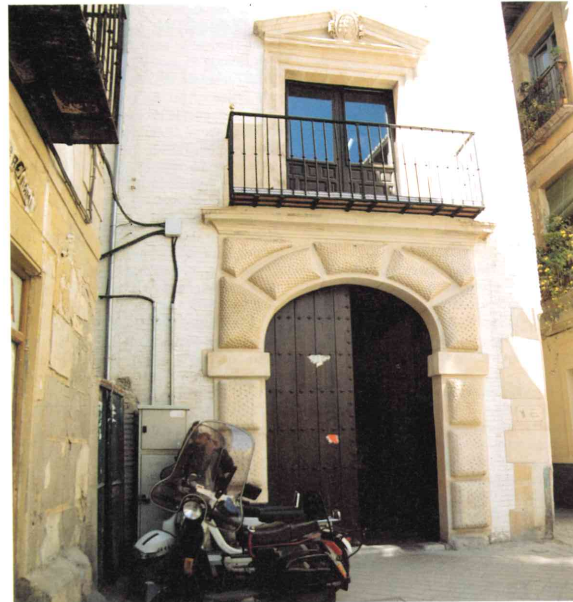
Edificio rehabilitado en la calle San Matías.
