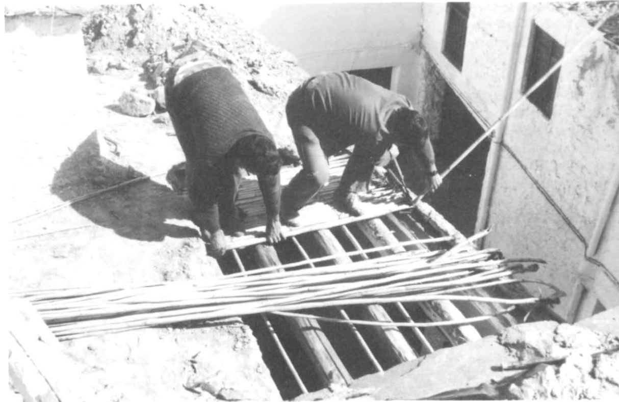
Reparación del forjado de cañas. (Cástaras).
