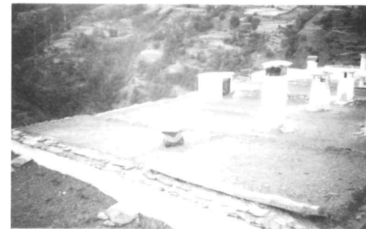
Elementos del terrado: chimeneas, bocanas, incluso se pueden ver los desagües sobre otros terrados y las juntas como consecuencia de la incorporación de los plásticos. (Capileira).
