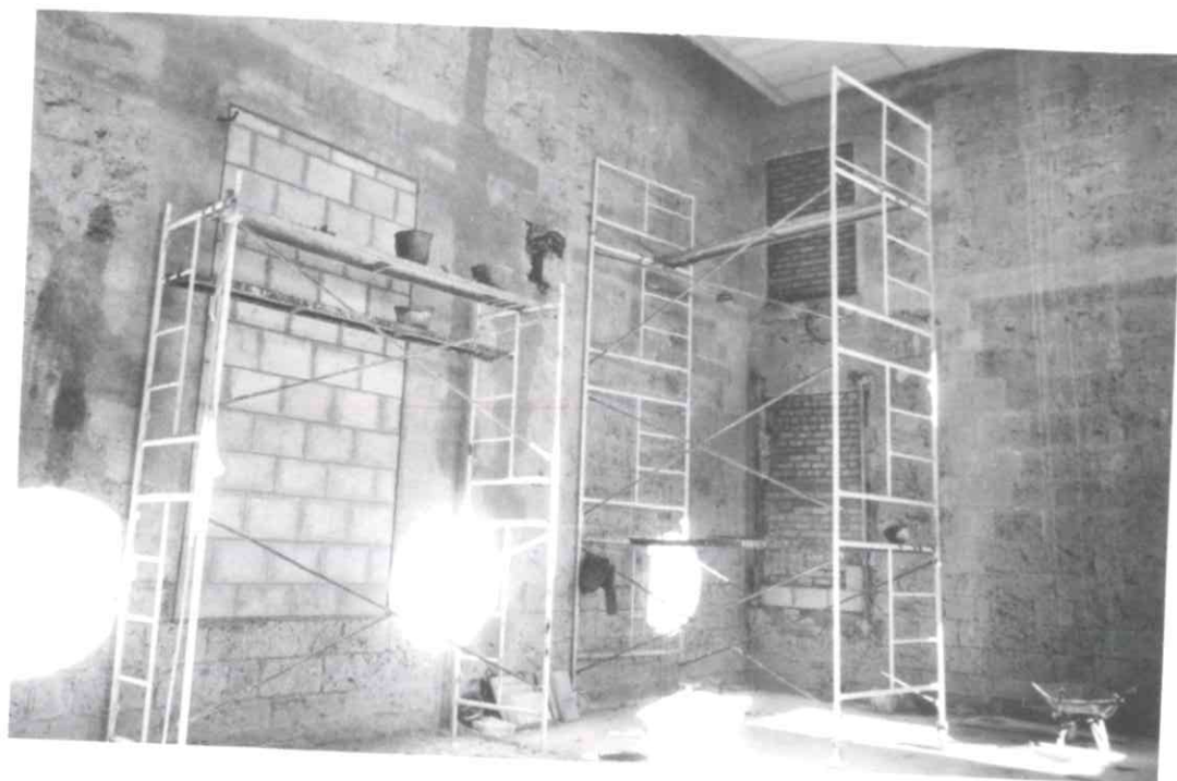
Proceso de cegado de huecos y revocos en rozas y zonas deterioradas.
