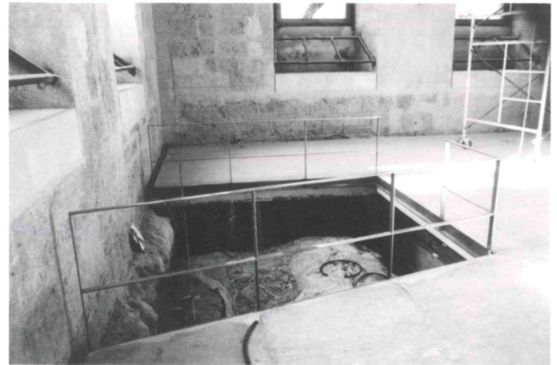
Antiguo Salón Dorado. En el centro, la zarpa del muro se derrama sobre los restos expuestos.
