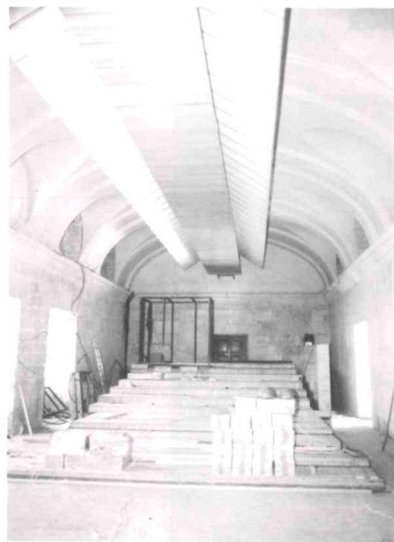
Lámpara. Techo del Salón de conferencias y gradas de roble.
