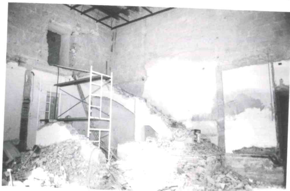
Revestimientos, cajeados, rozas y huecos contemporáneos por doquier.
