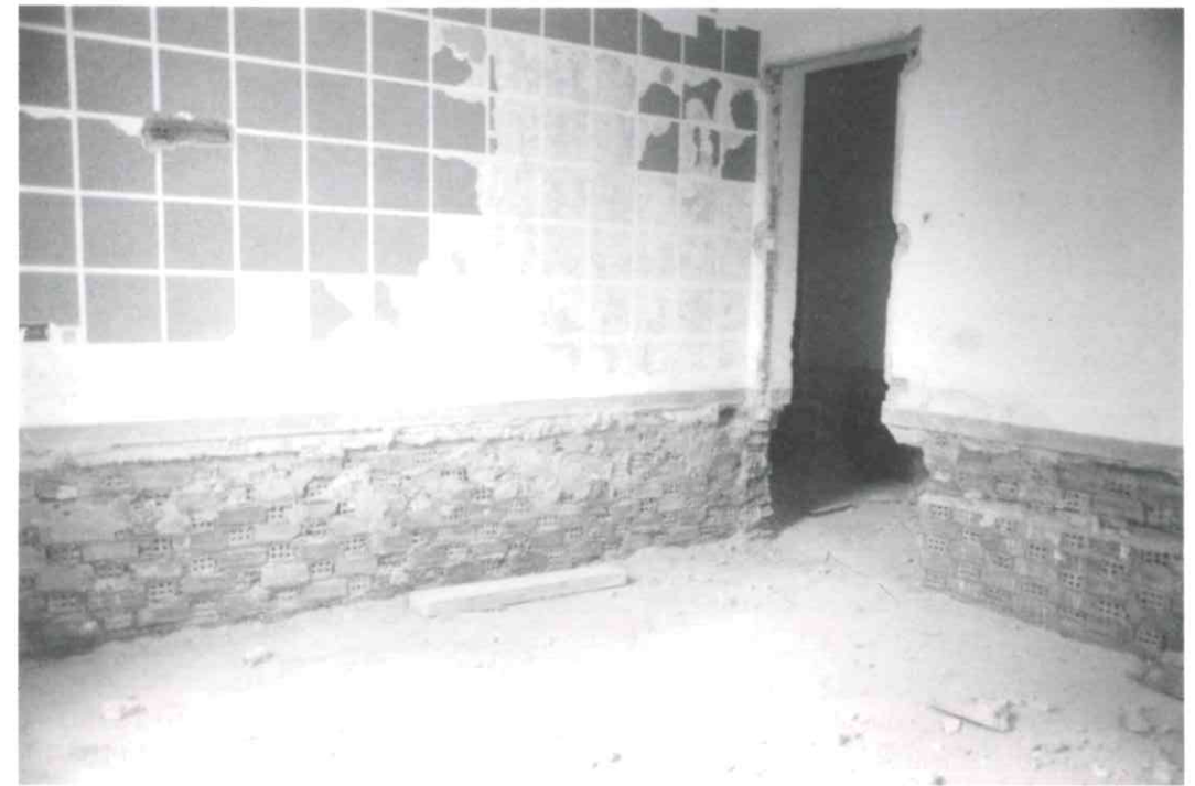
Antigua Oficina Técnica. Se observa la cota del empalomado demolido.
