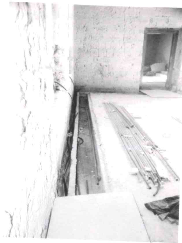
Detalle de la zanja de instalaciones. Se observa que, al igual que se separa del muro principal, dobla con el transversal para pasar por el hueco y no dañarlo.
