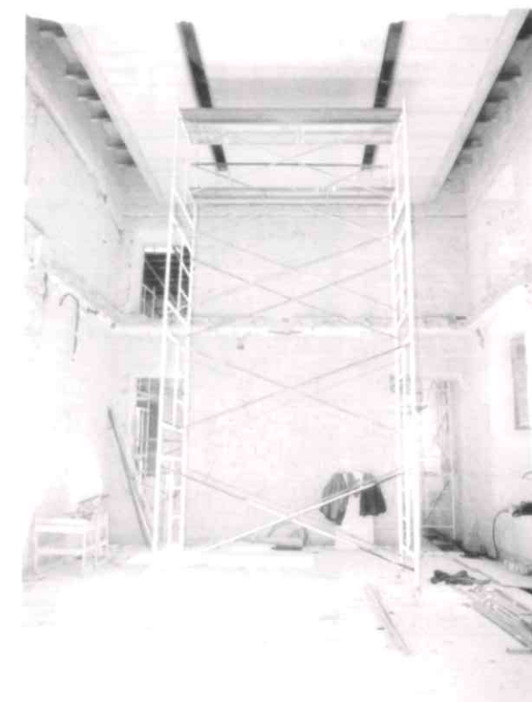
Falso techo tipo con las "rajadas" para iluminación y climatización.
