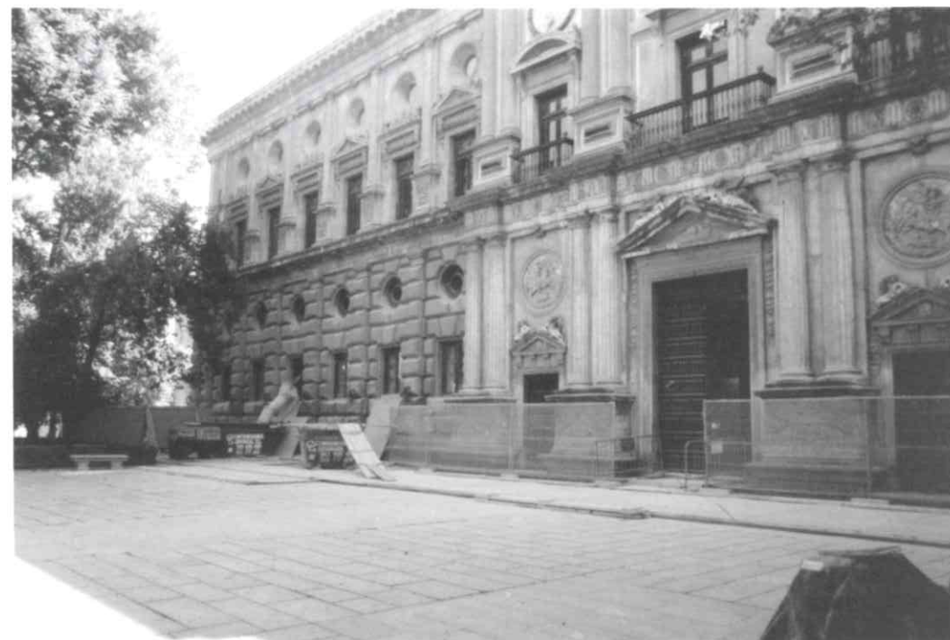
1ª Fase protecciones desescombros. Al fondo, trasdos del vallado autoportante de madera.
