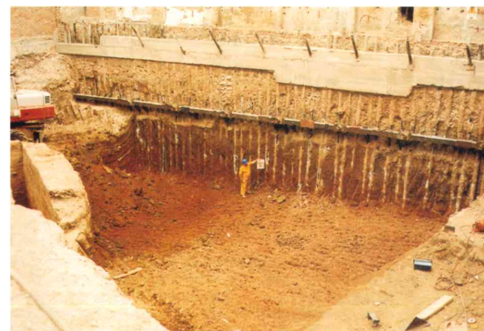
Imágenes del desarrollo del vaciado y extracción de maquinaria.
