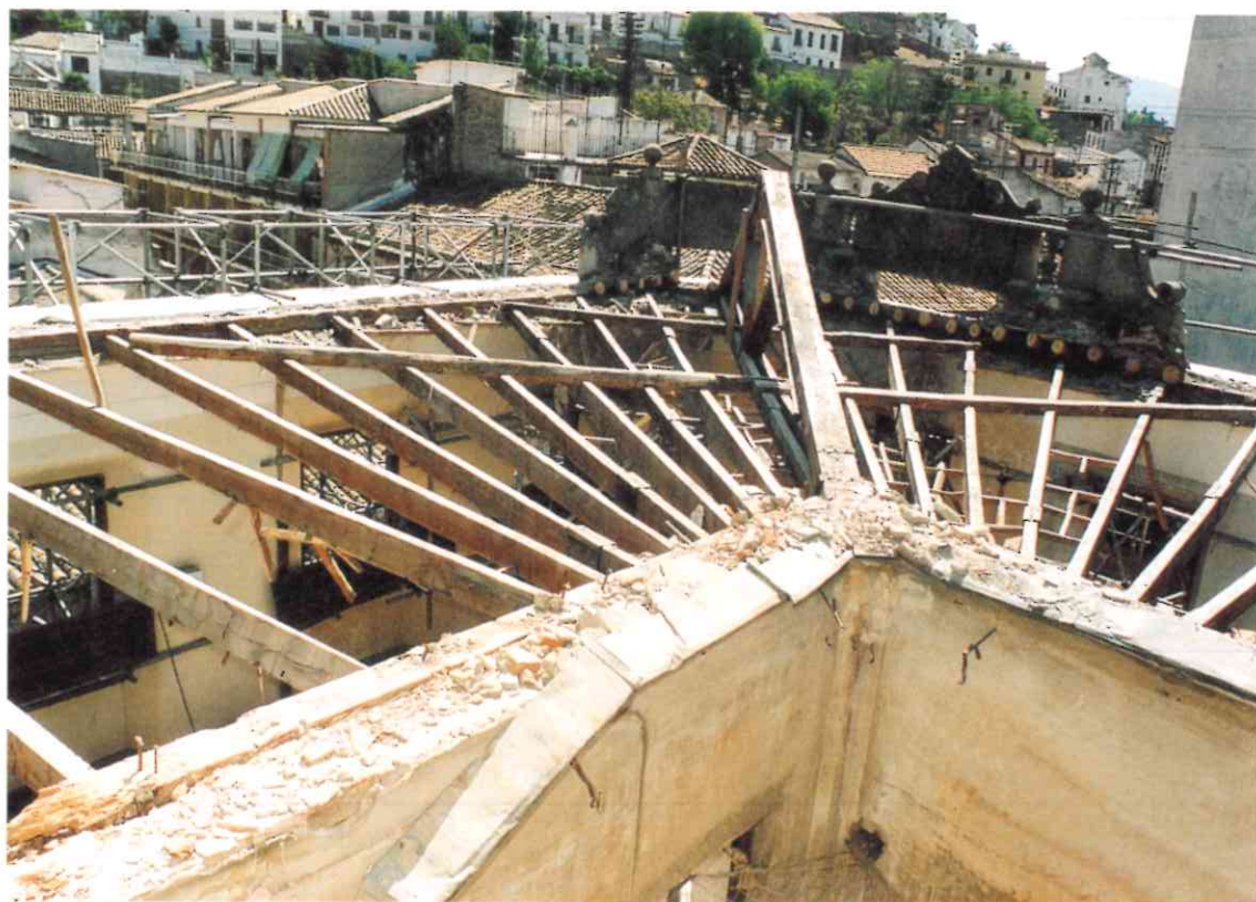
Fase del laborioso proceso de demolición.
