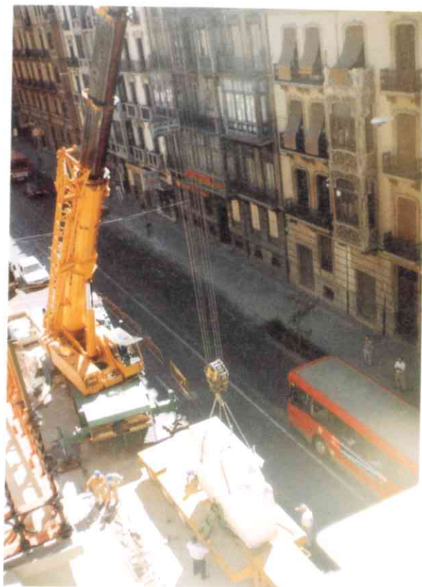
Momento en el que se procede a la retirada de lastres.
