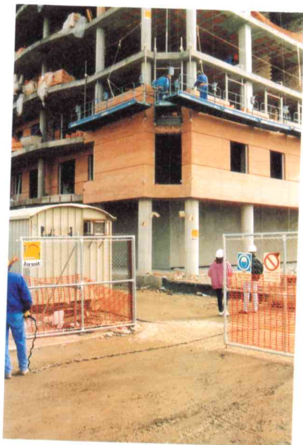
Alumnos durante la toma de datos en la obra.
