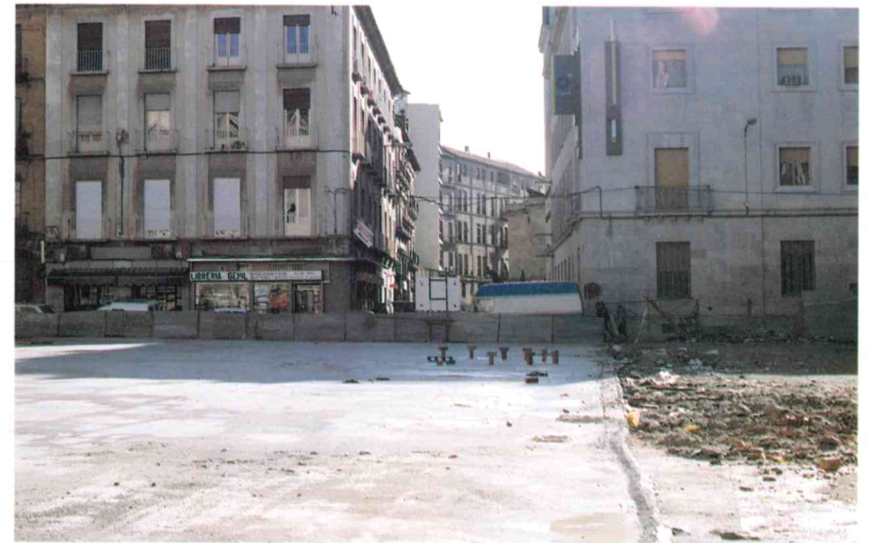
Estado en que se encuentran las obras del futuro Mercado de San Agustín.
