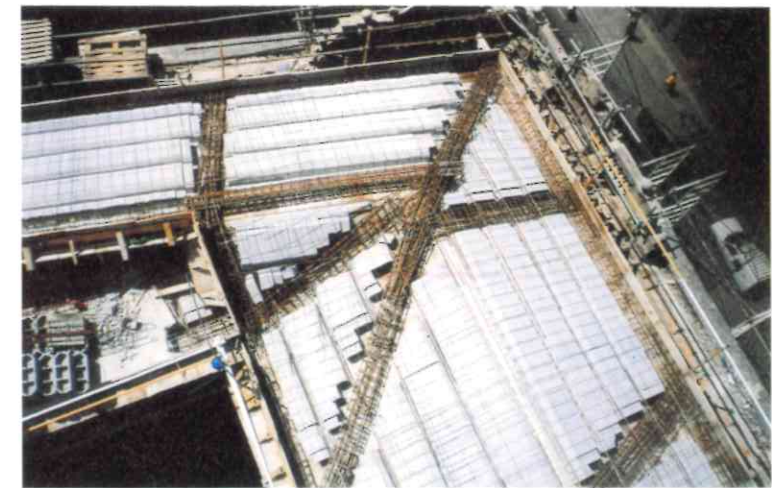
Imágenes de ejecución de la estructura.
