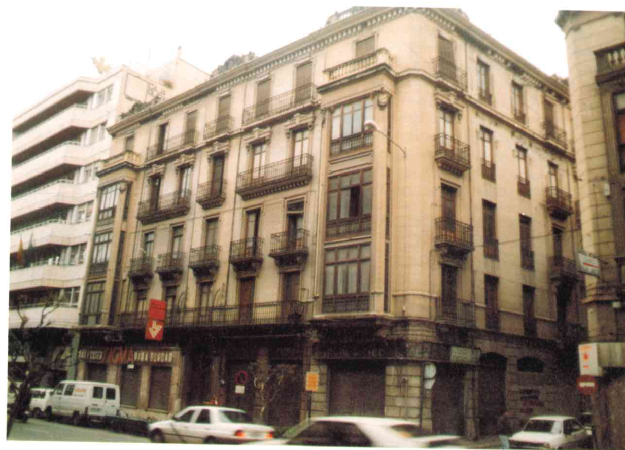
Aspecto exterior del edificio antes de la intervención realizada.
