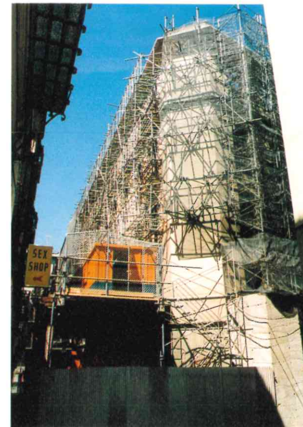
Vista de fachada estabilizada.
