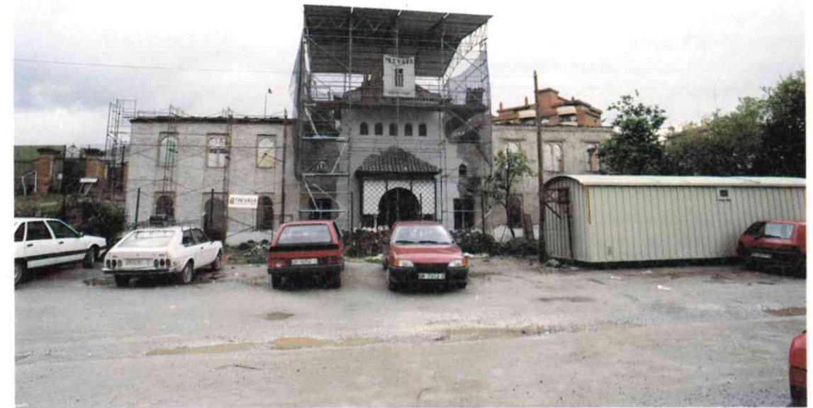
Vista del sistema de andamiaje utilizado para la restauración de la cubierta.
