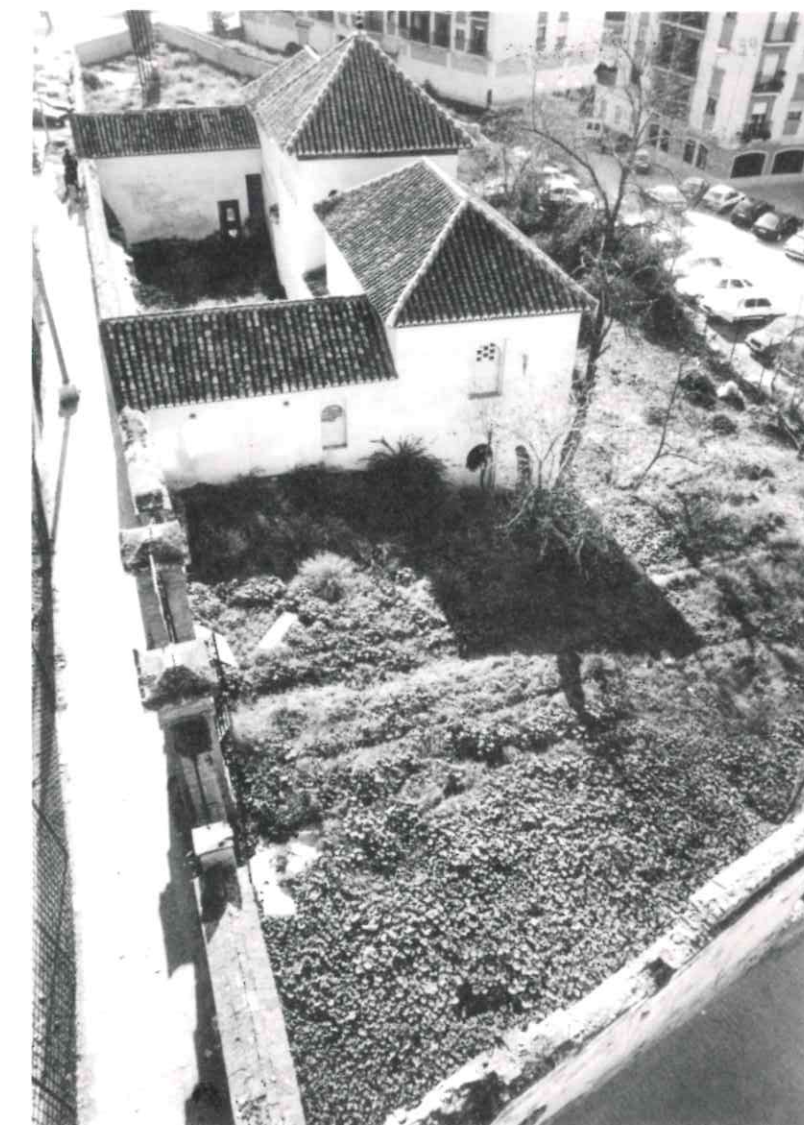
Vista general antes de la intervención.
