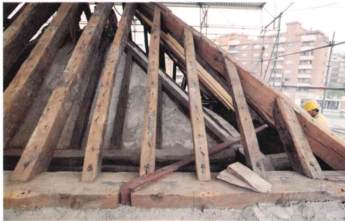
Otra vista de la estructura donde se distingue la armadura correspondiente al trabajo de lacería y la que organiza el plano externo de cubierta.
