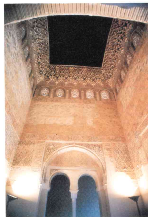
Interior de la "qubba" después de la restauración.
