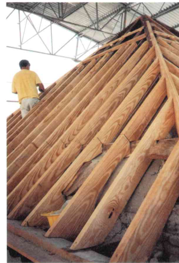
Regularización del plano exterior de cubierta mediante pares superpuestos.
