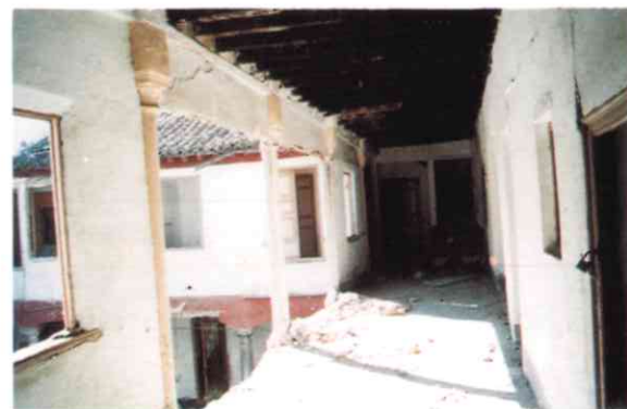
Foto 4. Estado previo galería superior.
