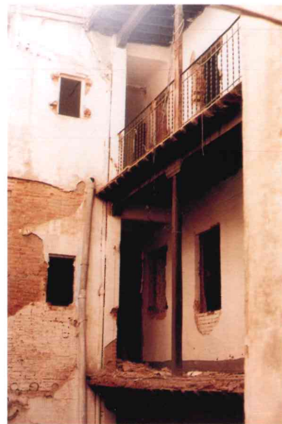
Foto 5. Estado previo patio edificación secundaria.
