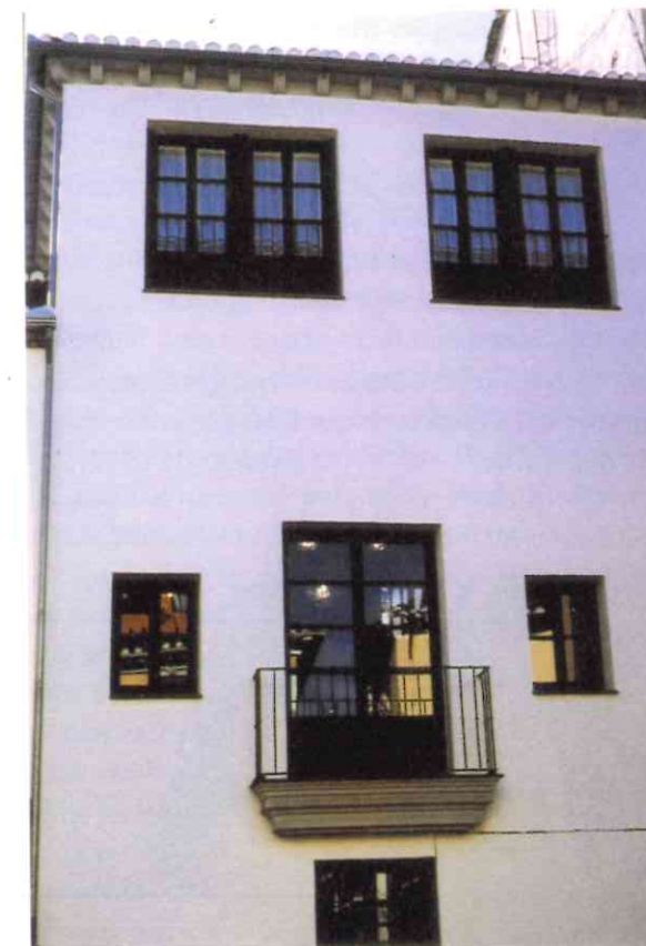
Foto 6. Estado final fachada principal.
