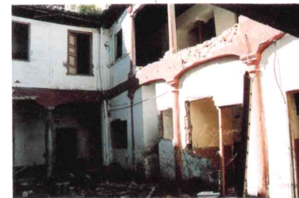
Foto 2. Estado previo patio central.
