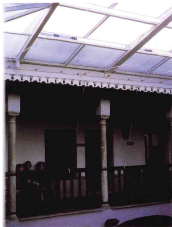
Foto 11. Estado final galería superior.
