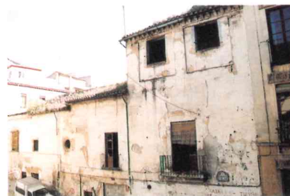
Foto 1. Estado previo fachada principal.
