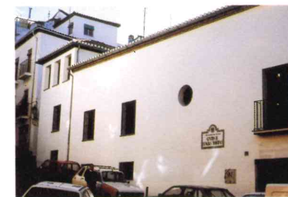
Foto 7. Estado final fachada principal.
