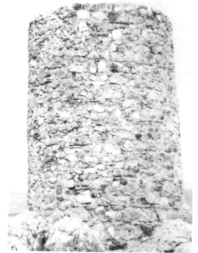
Foto nº 7: Torre de Mingoandrés (Moclín), después de la restauración.
