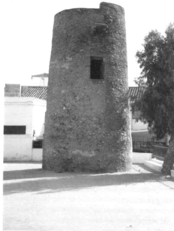
Foto nº 2: Torre Torrenueva (Motril).
