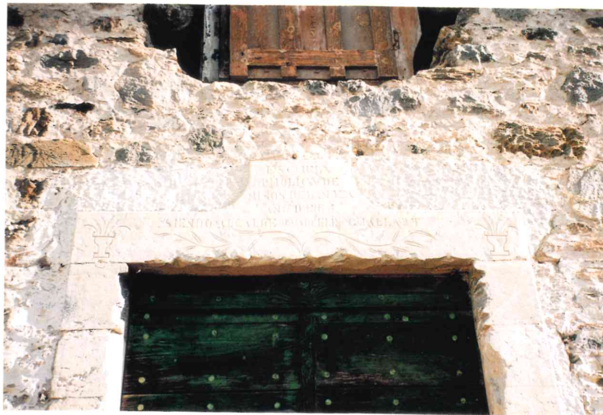
Dintel de la puerta de entrada de una de las casas.
