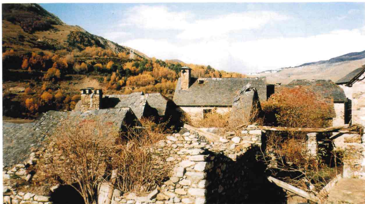
Detalle del caserío existente.
