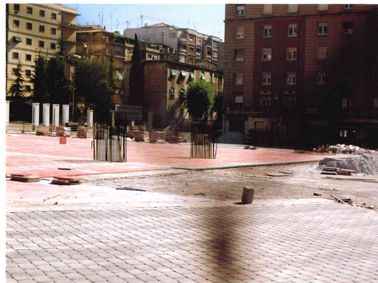
Obras en La Caleta.
