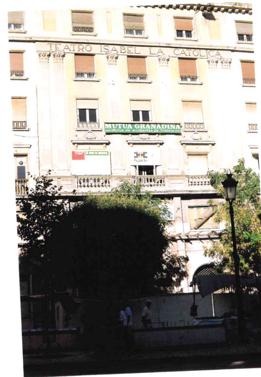
Fachada del Teatro Isabel la Católica, aún sin terminar.
