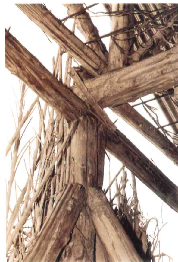
Detalle del nudo central de un secadero de palos a nivel de cubierta.
