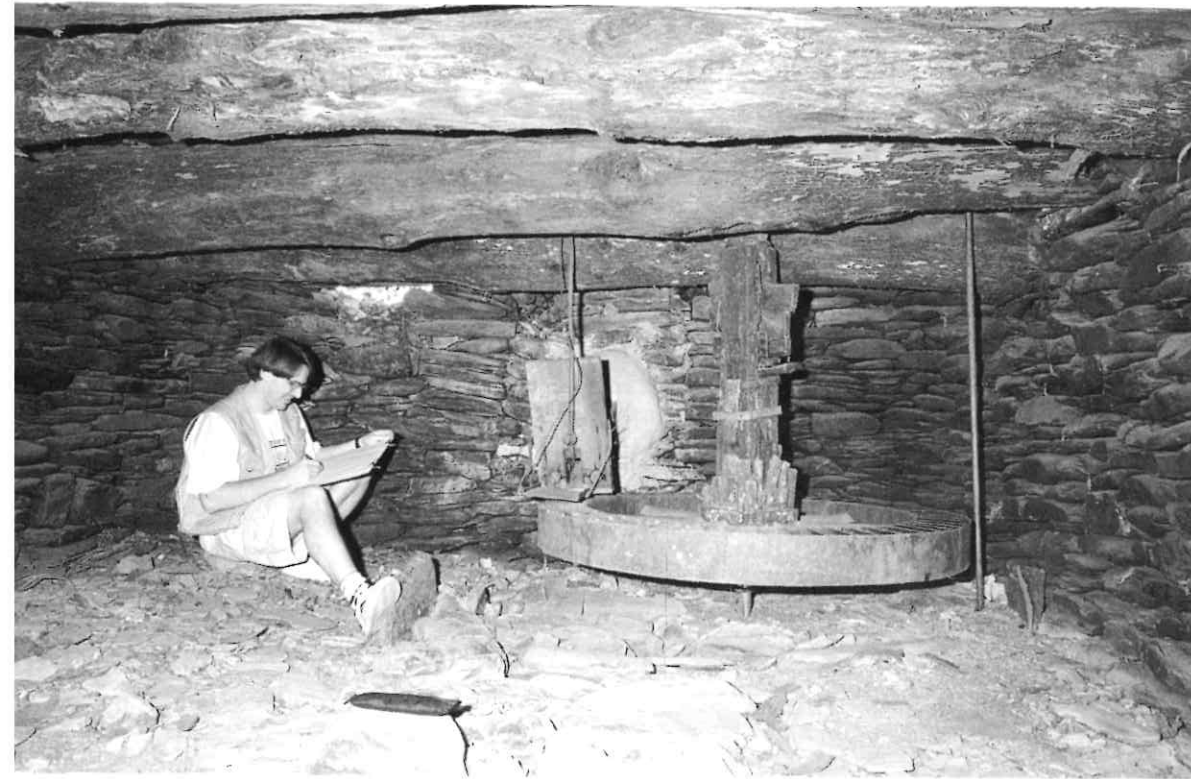
Croquización y toma de datos en el cárcavo del Molino de Benjamín (Aldeire).
