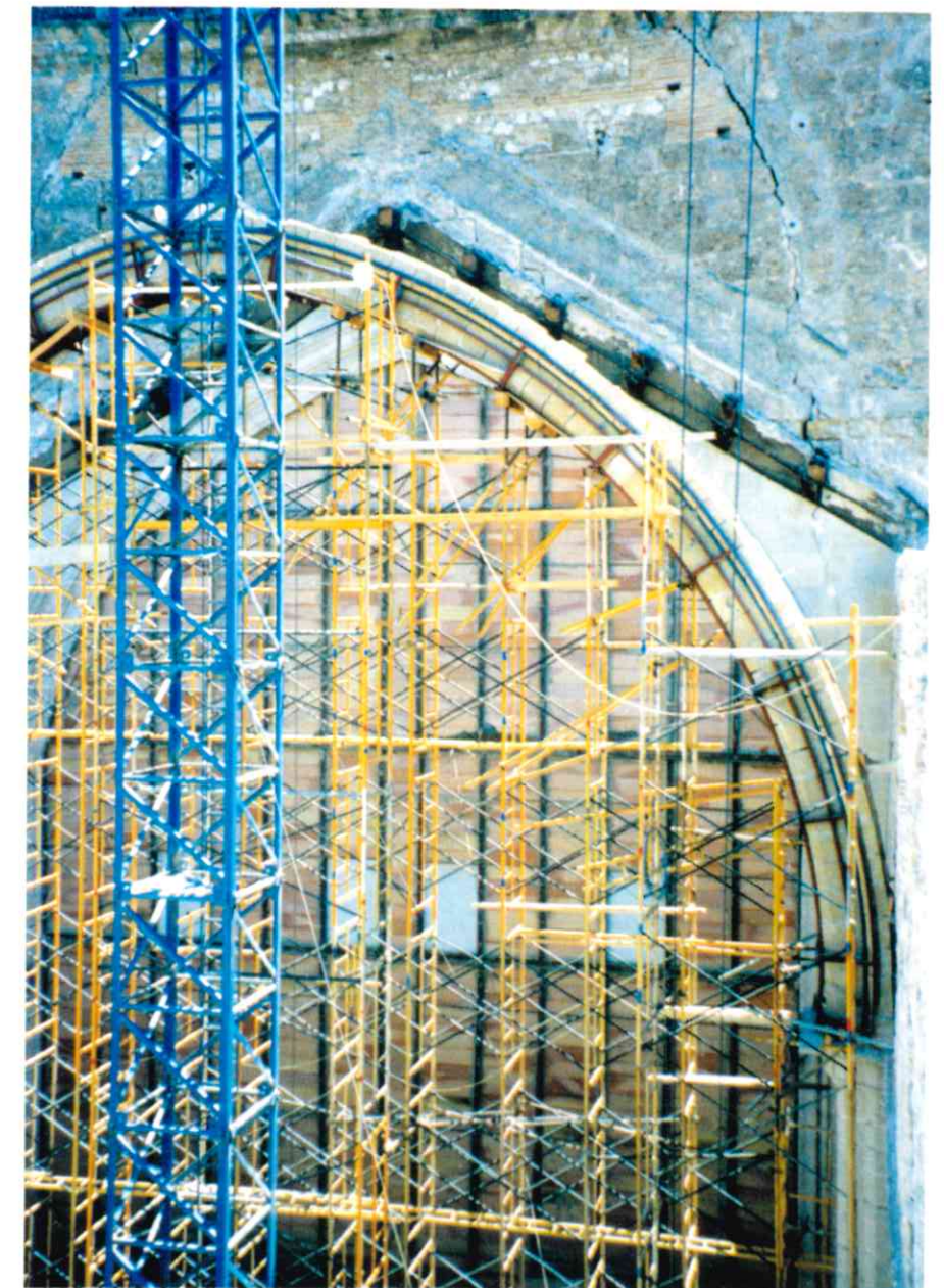
Ejecución del primer arco de sillería.
