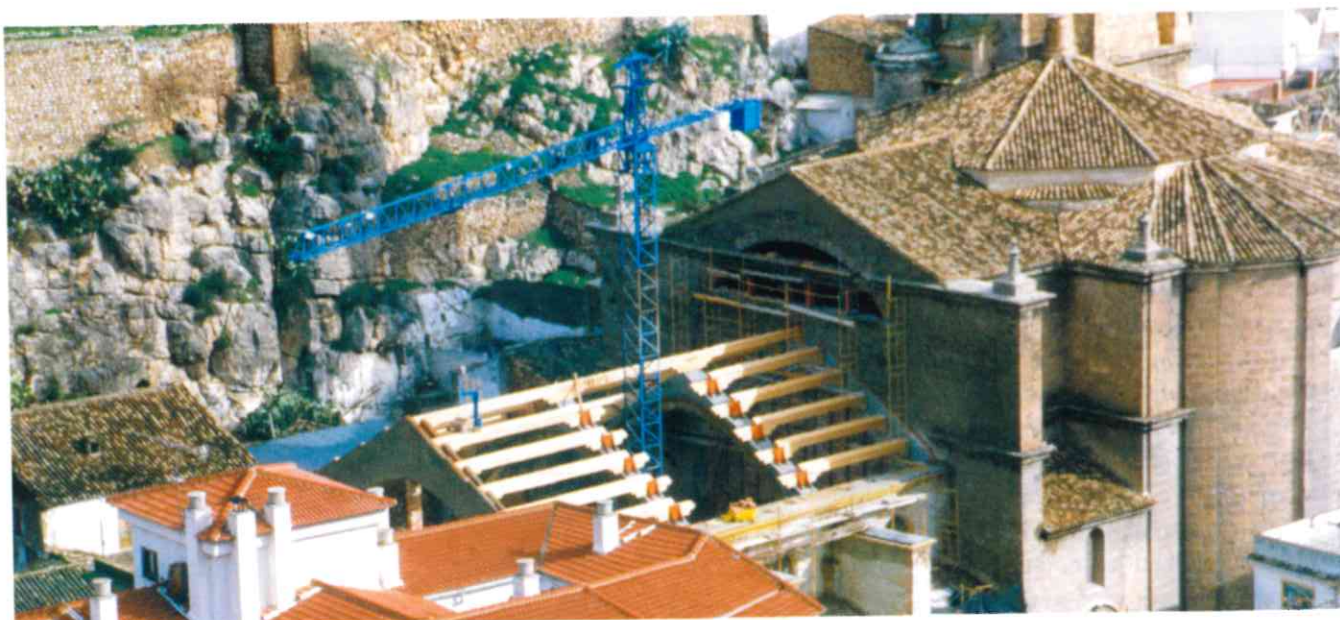
Vista de la nave en restauración y su relación con la cabecera construida en el siglo XVIII.
