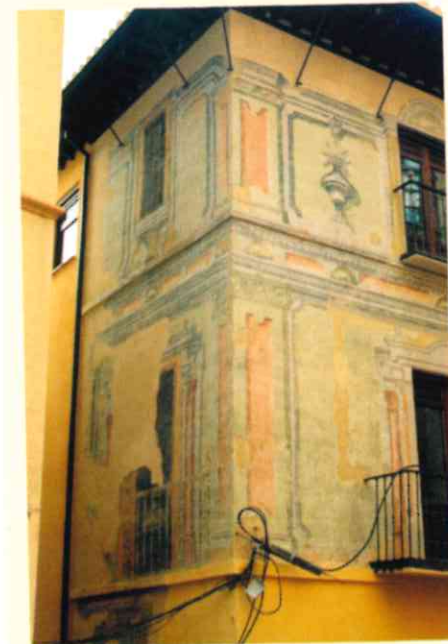
Vista general del encuentro de fachadas antes y tras la intervención.
