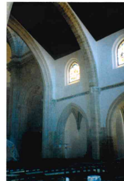
Interior de la nave una vez terminada su restauración.
