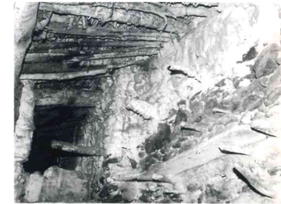
Detalle de cómo se construye una estantería.
