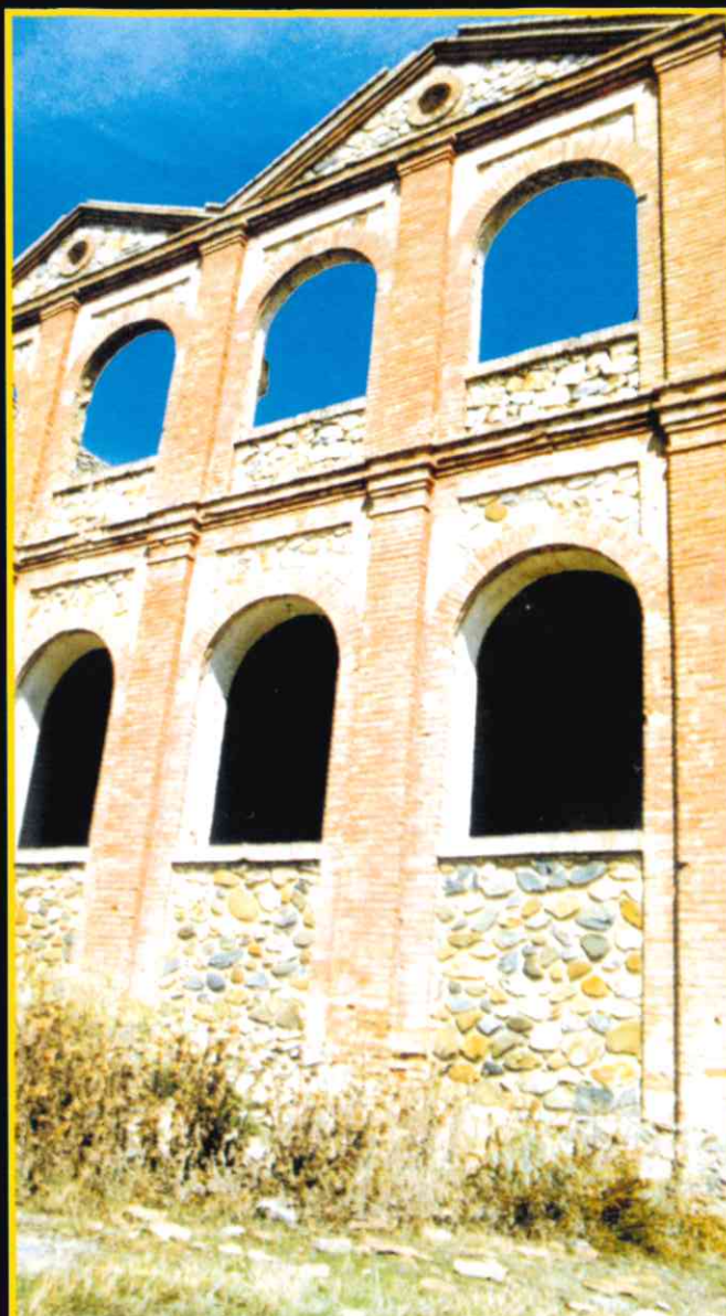
[Fig. 12] Fachada del edificio principal
