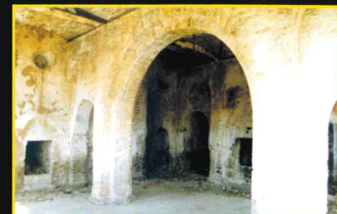
[Fig. 10] Interior de la planta baja, posible comedor
