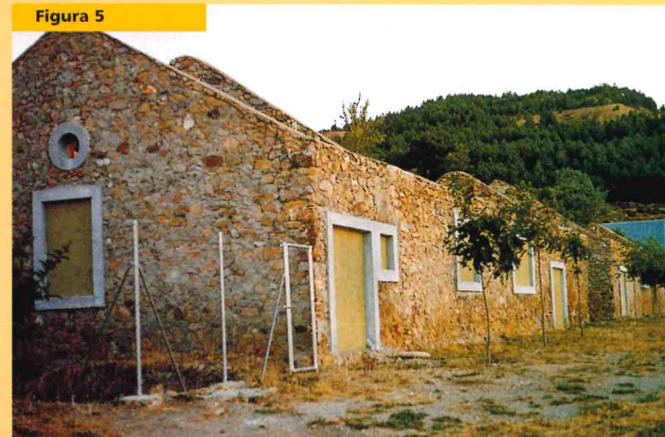
Figura 5 Economato y panadería en la época minera. Su recuperación será como escuela taller.
