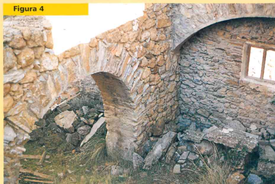
Figura 4 Estado de la primera planta de los talleres.
