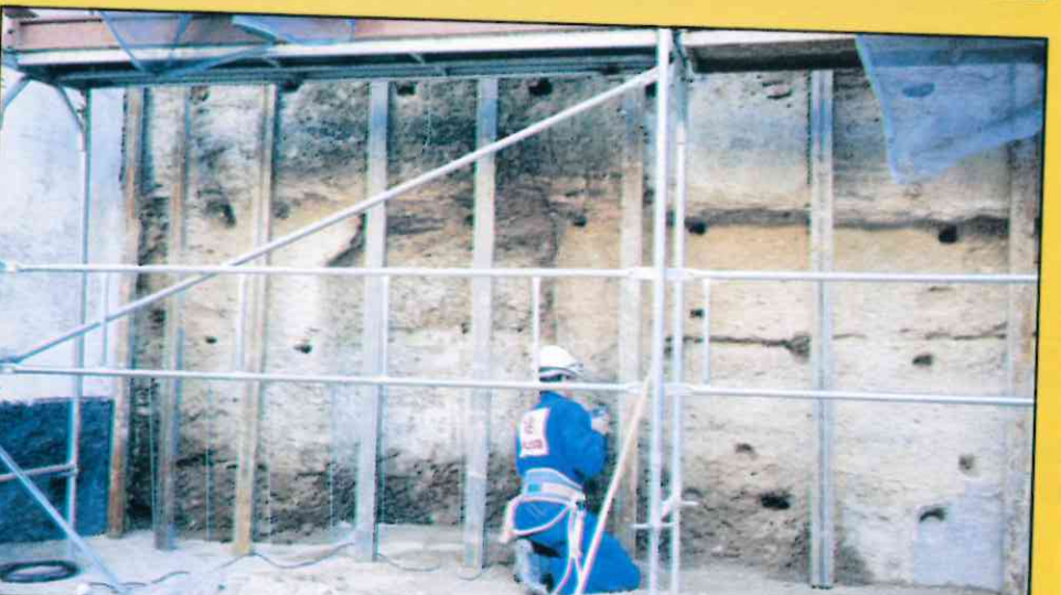
ARCO DE LAS PESAS. Trabajos de limpieza y retirada de añadidos y rellenos en las zonas inferiores de la muralla.
