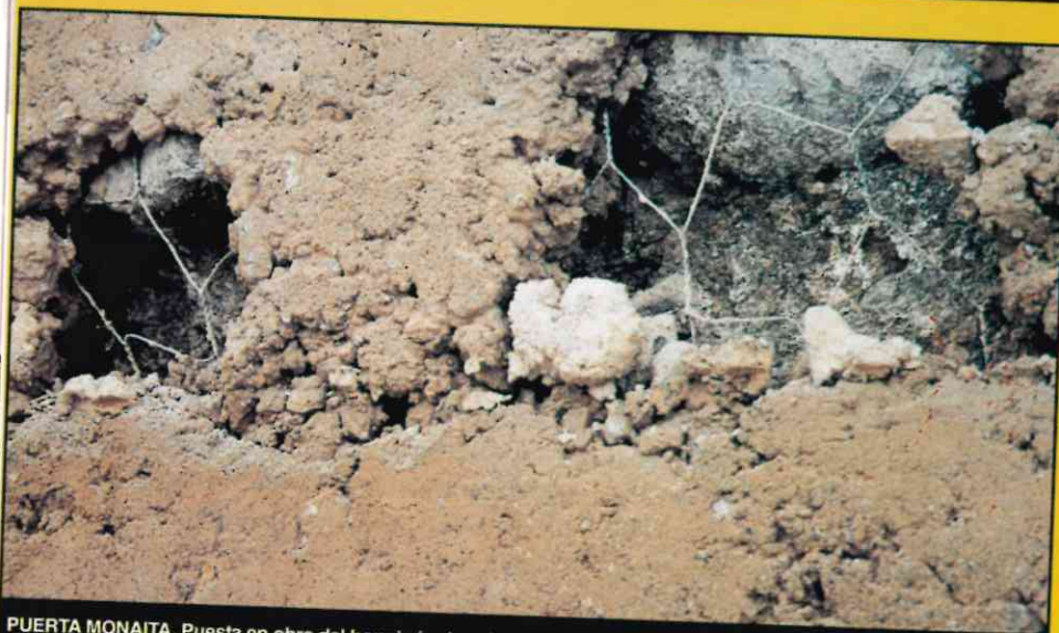
PUERTA MONAITA. Puesta en obra del hormigón de cal con el que se han consolidado las fábricas de tapial antiguas.
