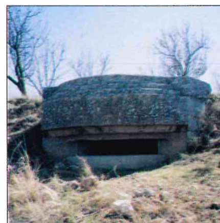
Aspecto exterior del búnker subterráneo.
