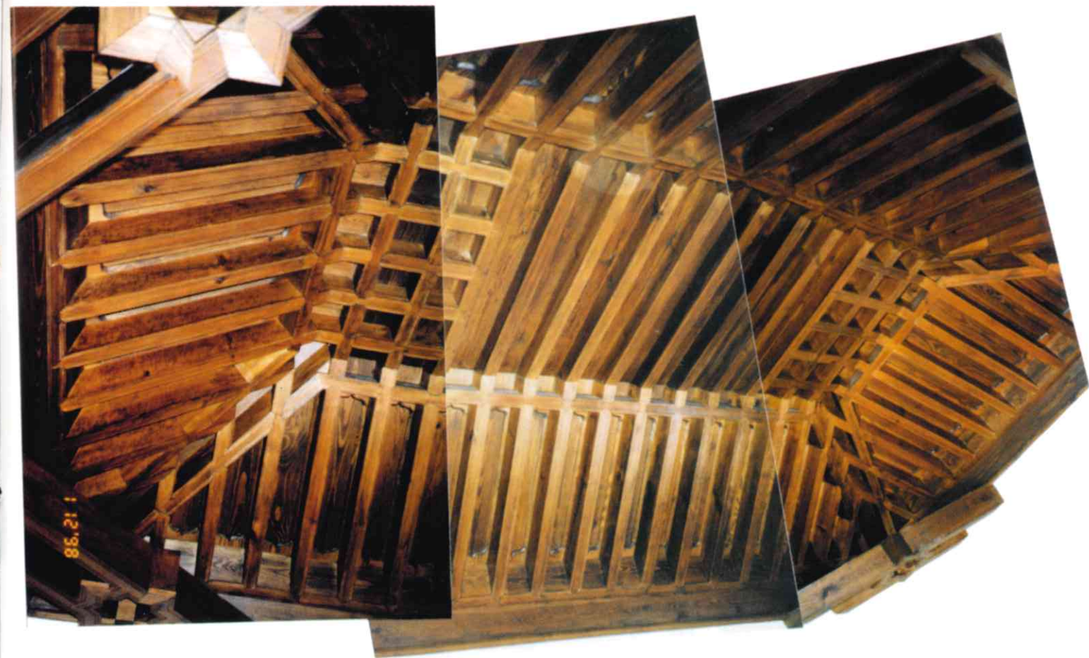
Vista del artesanado que conforma el techo del dormitorio de esquina.
