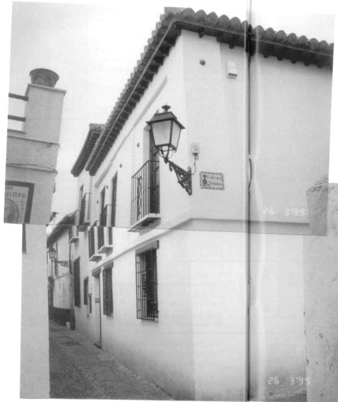
Imagen final de la esquina de la casa. Las instalaciones se han canalizado bajo el pavimento. Los aleros y balcones mantienen la impronta original.
