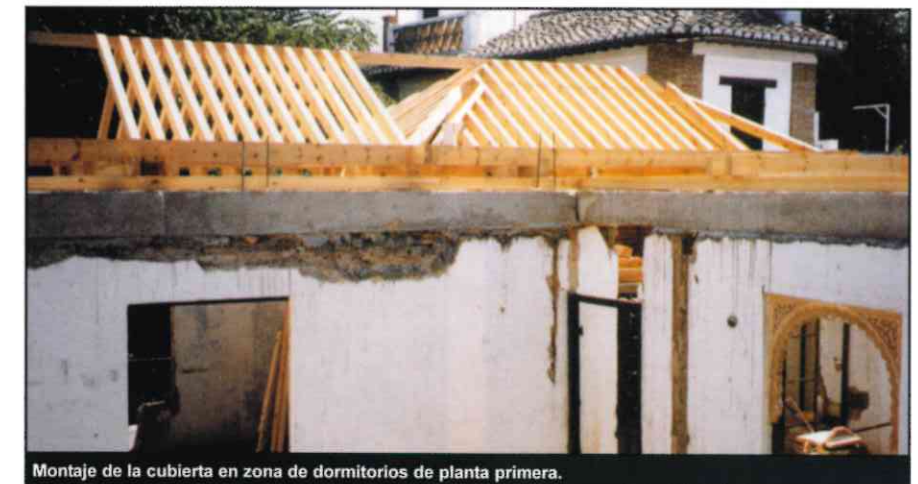
Montaje de la cubierta en zona de dormitorios de planta primera.
