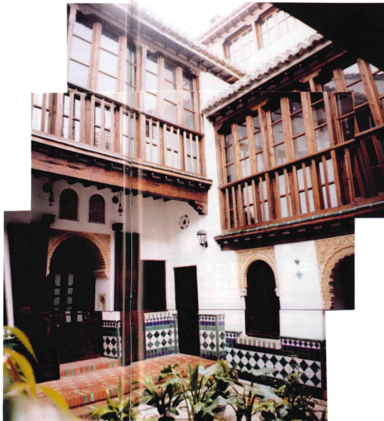
Aspecto de la esquina noreste del patio tras la rehabilitación.
