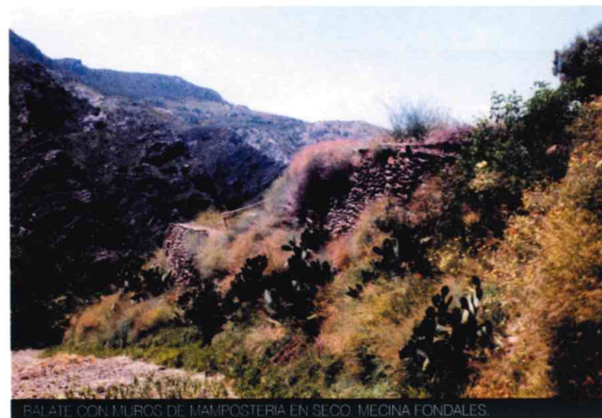
BALATE CON MUROS DE MAMPOSTERÍA EN SECO. MECINA FONDALES.
