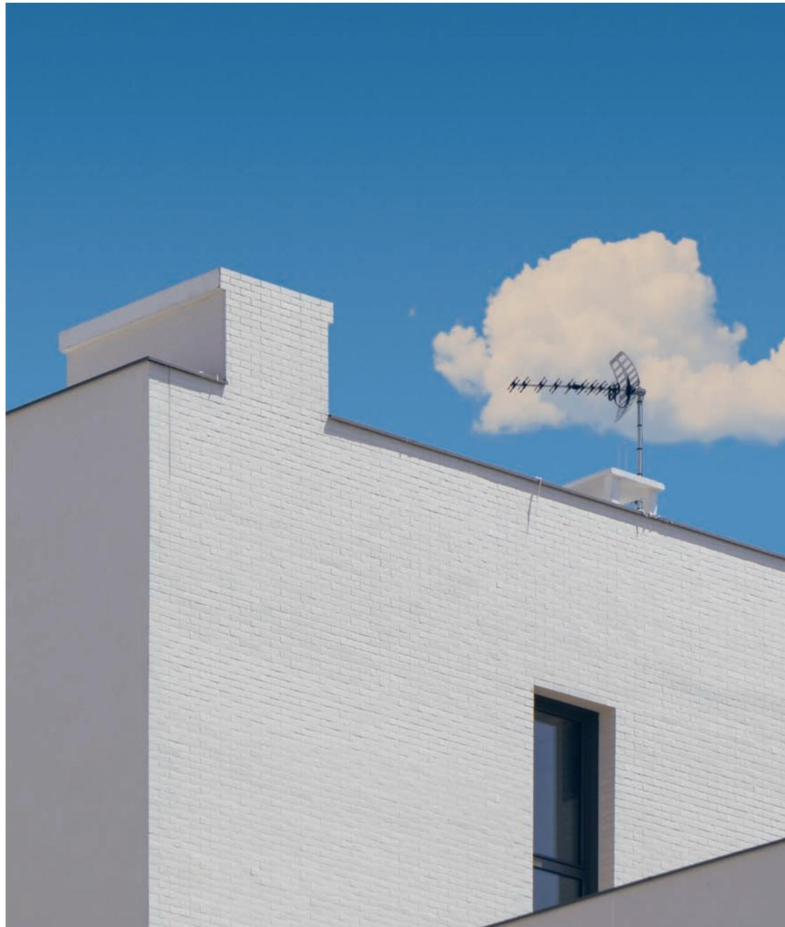
“La característica fundamental es la continuidad de la hoja exterior de la fachada, que se construye como un paño separado de la estructura del edificio, sin interrumpirse ni estrangularse a su paso por delante de los frentes de forjado y pilares, ...”
