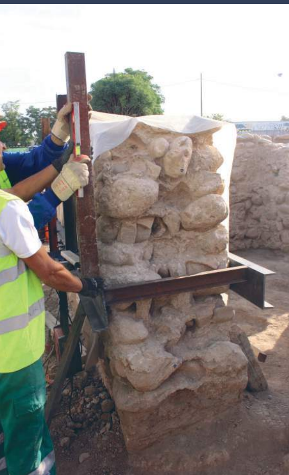
Figura 6. Proceso de desmontaje del edificio religioso. Construcción de estructura metálica.
