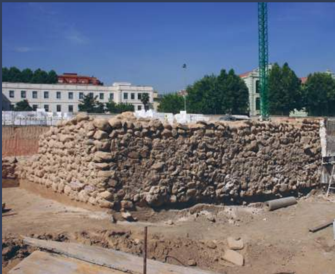
Figura 7. Proceso de desmontaje del edificio religioso. Detalle de los sectores de corte y encofrado
