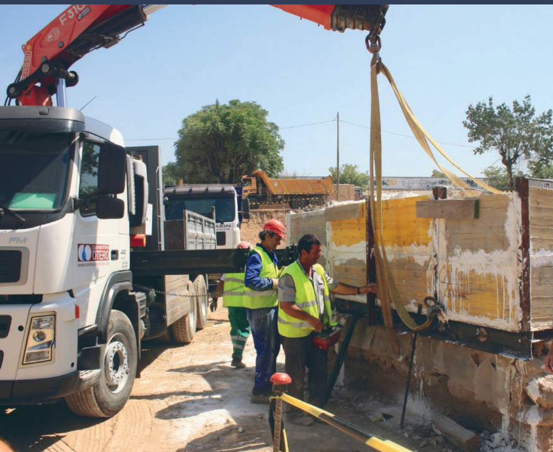
Figura 9. Proceso de desmontaje del edificio religioso. Arranque y traslado a un punto de acopio.
