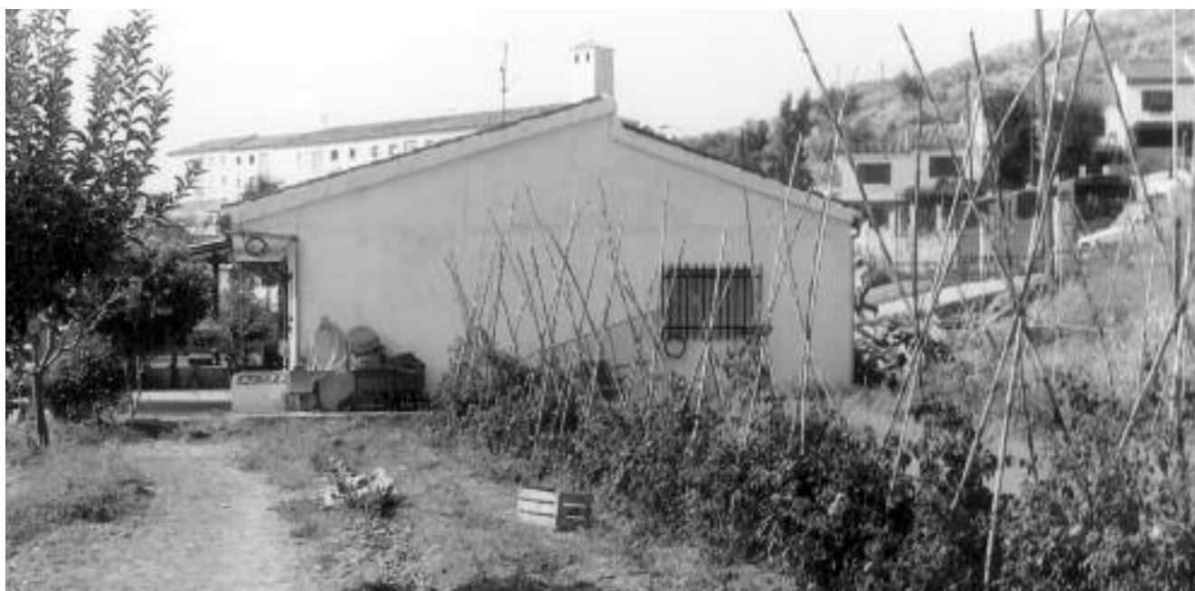
Arriba, casa en La Vega expedientada por el Ayuntamiento. Abajo, vivienda ya demolida en la Lancha de Cenes.
