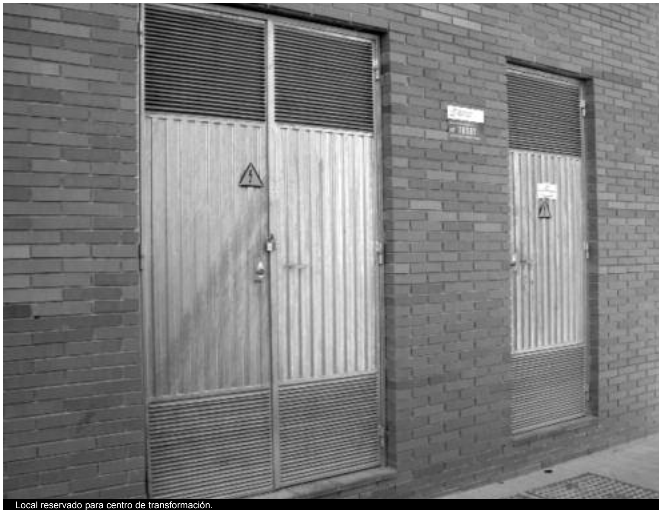
Local reservado para centro de transformación.
