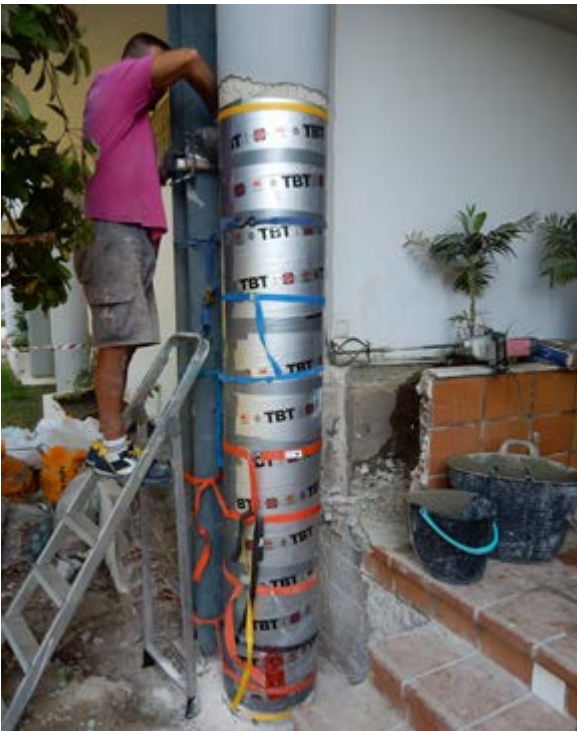
Ilustración 5. Detalle del encofrado del pilar.
