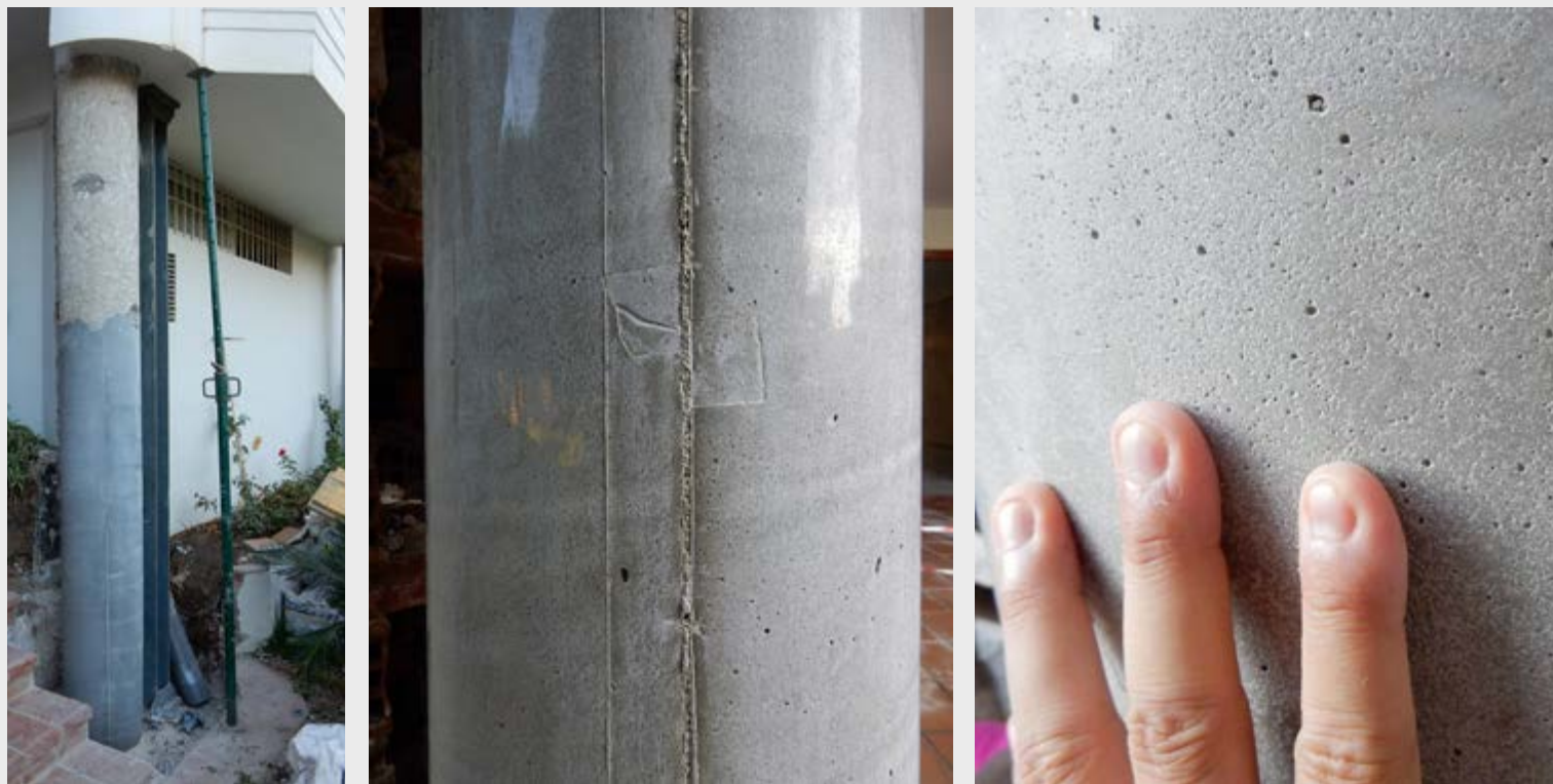
Ilustración 6. Textura resultante una vez lijada la superficie para abrir el poro del mortero
