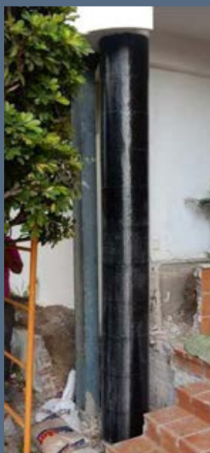
Ilustración 9. Colocación de tejido de fibra de carbono, adherido sobre el soporte. Primera vuelta.
