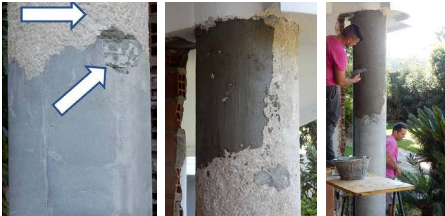
Ilustración 7 - Regularización superficial de la parte superior del pilar realizada con Morcemseal Todo 1 R4.
