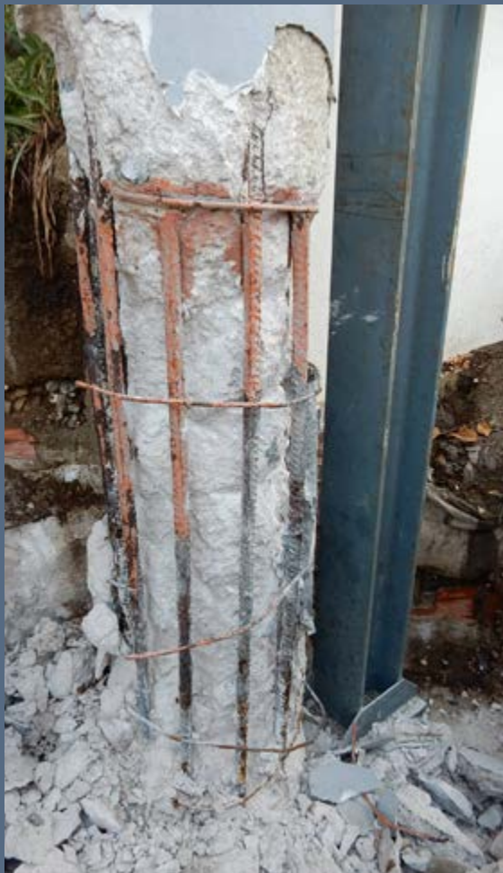
Ilustración 2. Labores de picado del hormigón en mal estado.
