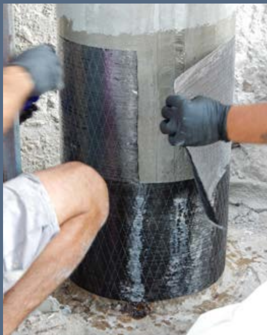
Ilustración 9. Colocación de tejido de fibra de carbono, adherido sobre el soporte. Primera vuelta.
