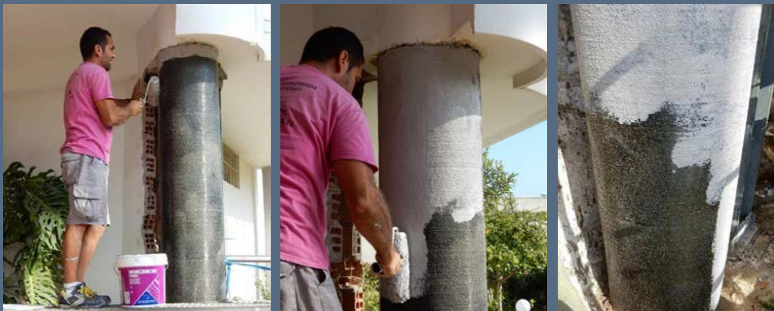
Ilustración 12. Aplicación con rodillo de puente de unión acrílico (Fondo Morcemcrl).
