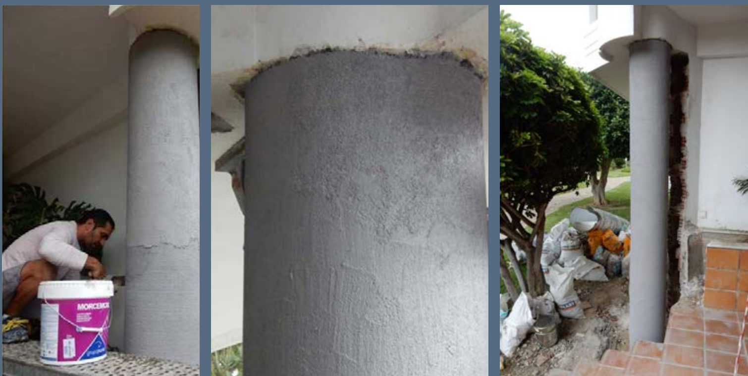
Ilustración 14. Aplicación de acabado acrílico (Mortero Morcemcrl). Posteriormente fratasado con llana de plástico.
