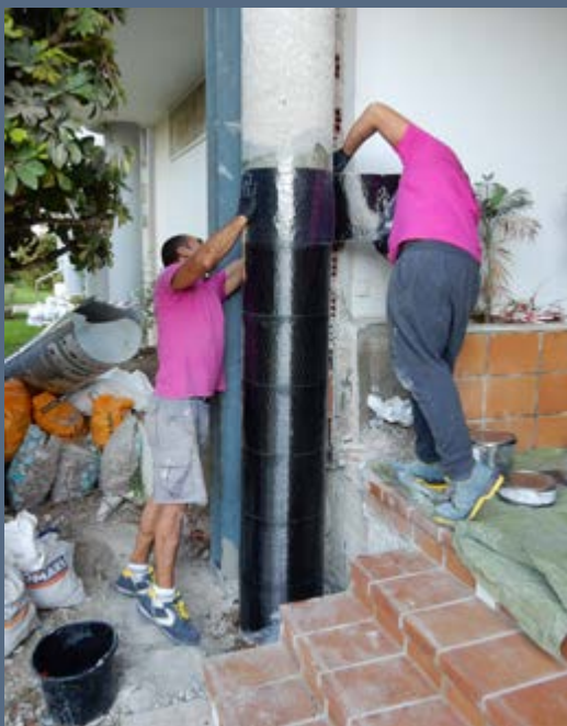
Ilustración 9. Colocación de tejido de fibra de carbono, adherido sobre el soporte. Primera vuelta.
