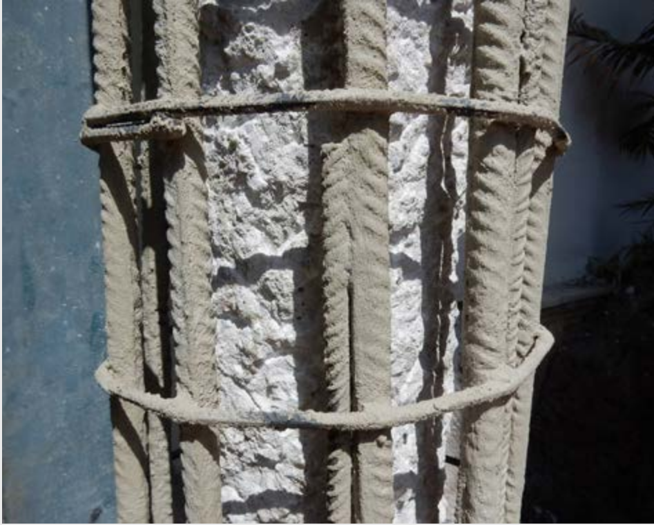
Ilustración 4. Vista de armaduras pasivadas mediante la aplicación de Implarest C.
