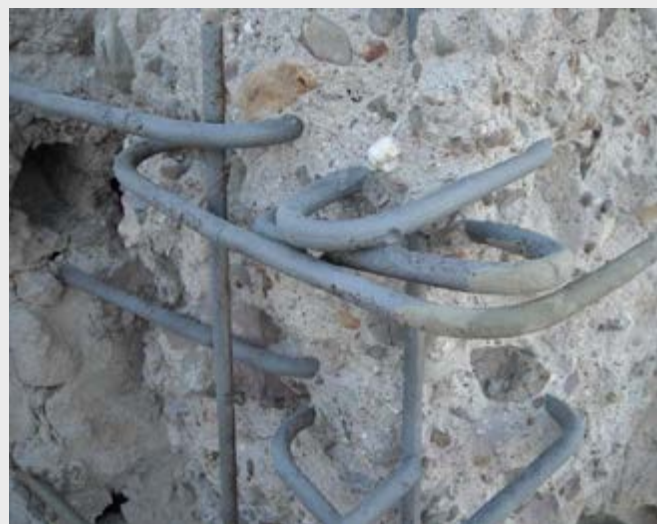
Ilustración 3. Limpieza de barras para eliminación de capa de óxido.
