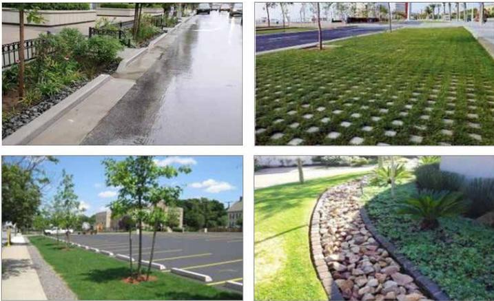
Figura 2. SuDS de Infiltración (SUSDRAIN, 2014)
