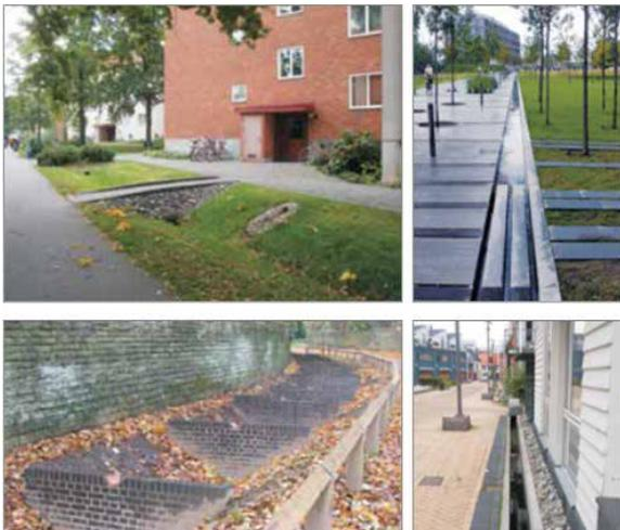
Figura 3. SuDS de Retención (SUSDRAIN, 2014)
