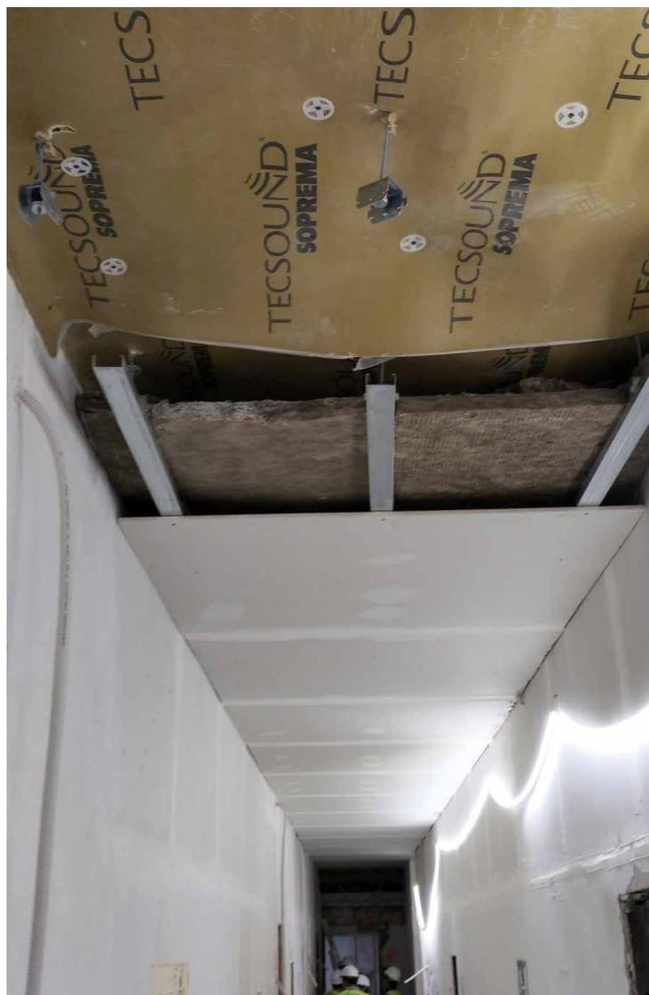
**E**l techo que cierra la caja superiormente está compuesto por 2 placas de yeso laminado de 13 mm de espesor sobre perfilería metálica y anclada a forjado existente mediante amortiguador AMC Akustik 1+Sylomer 30. En la cámara resultante se incluirán 2 paneles de lana mineral de 50 mm de espesor y no más de 30 kg/m<sup>3</sup>.
