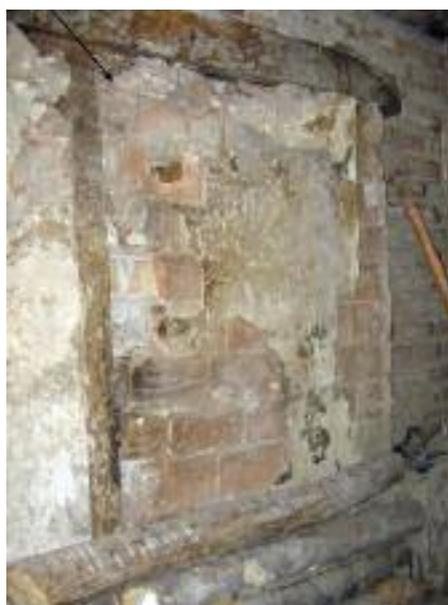
Arriba, zapatas de madera con círculo rebajado para el encastre del machón del pilar. Abajo, hueco entre medianeras enmarcado, pié derecho y zapata de apoyo en madera.
