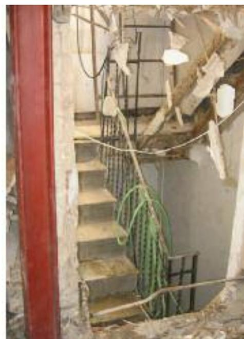
Diferentes detalles de la nueva estructura, cordón soldadura en jácena, tochos refuerzo en muro, hormigón y mallado, escalera antigua con las zancas de madera.
