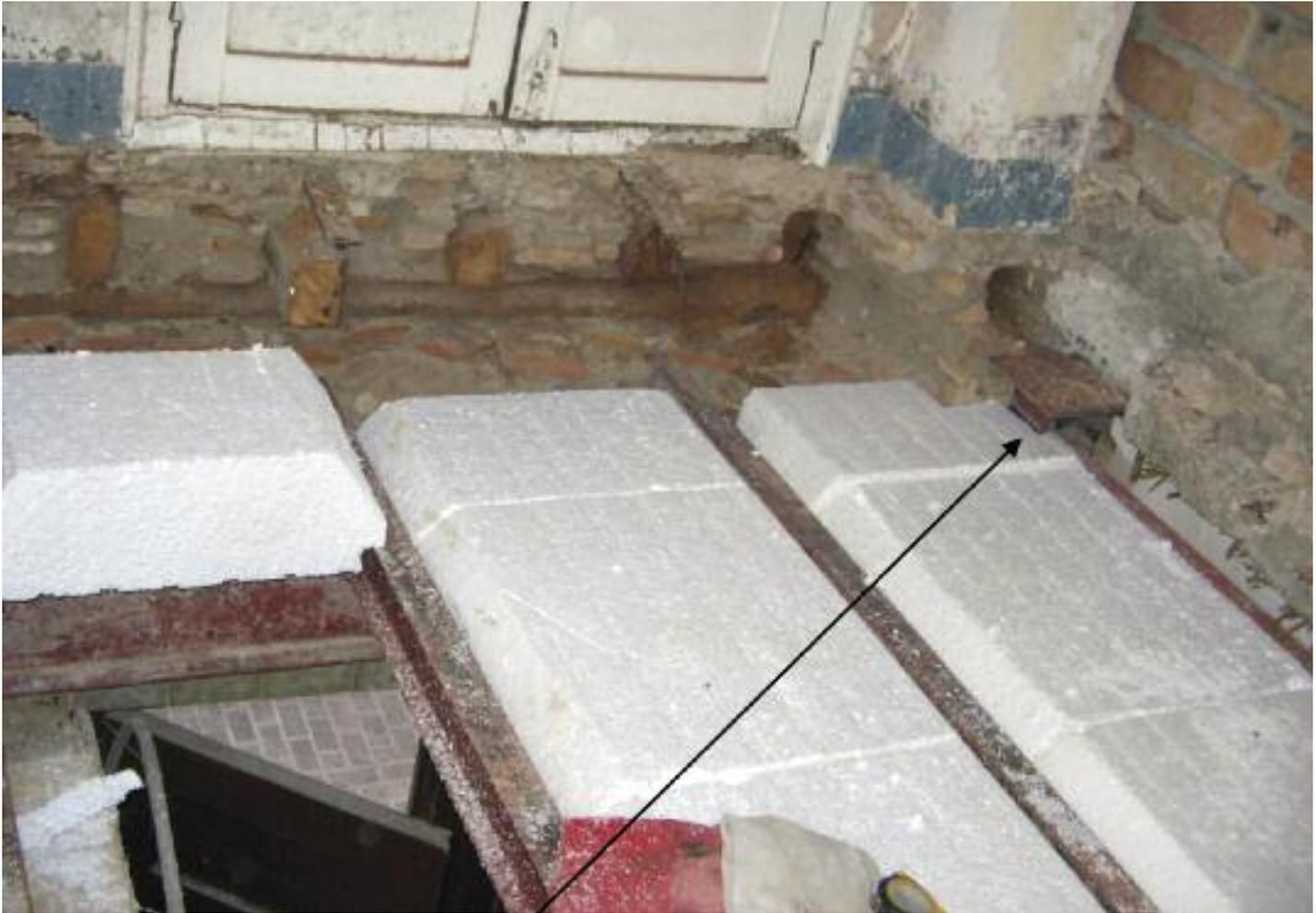
**Detalle de forjado nuevo, pilar metálico en la esquina y vigas de acero bovedilla de poliestireno, y restos forjado de madera en el muro de fachada.**
