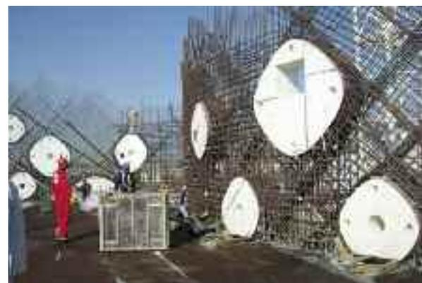
**Diseño específico de piezas de encofrado para la generación de perforaciones en el muro de hormigón en el proyecto de Ras-cielos 0.14. Dubai. MAD architects.**
