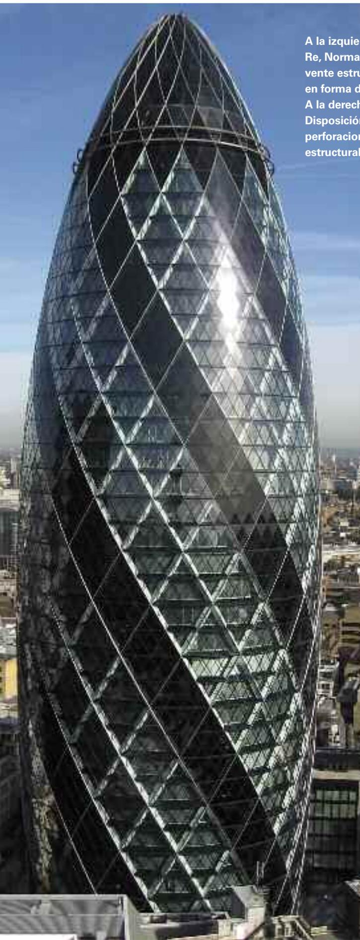
A la izquierda, edificio Swiss Re, Norman Foster. Envolvente estructural metálica en forma de diamante.
