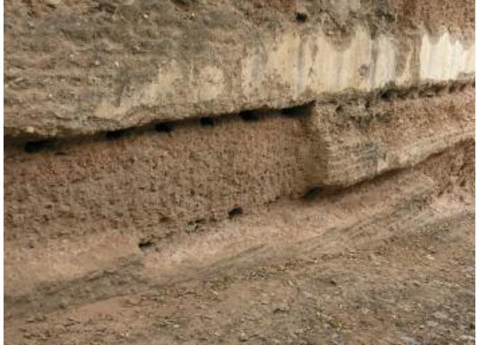
**Figura 1. Base de un tapial de la huerta del Generalife en La Alhambra, Granada (España) con pérdida de masa (arriba). Fase final de la aportación mediante proyección (centro). Resultado final de la consolidación y estabilización después de dos años (abajo).**
