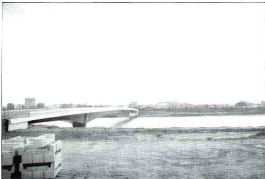
Lo más urgente ha sido enlazar, a través de puentes, las dos orillas del Guadalquivir.
