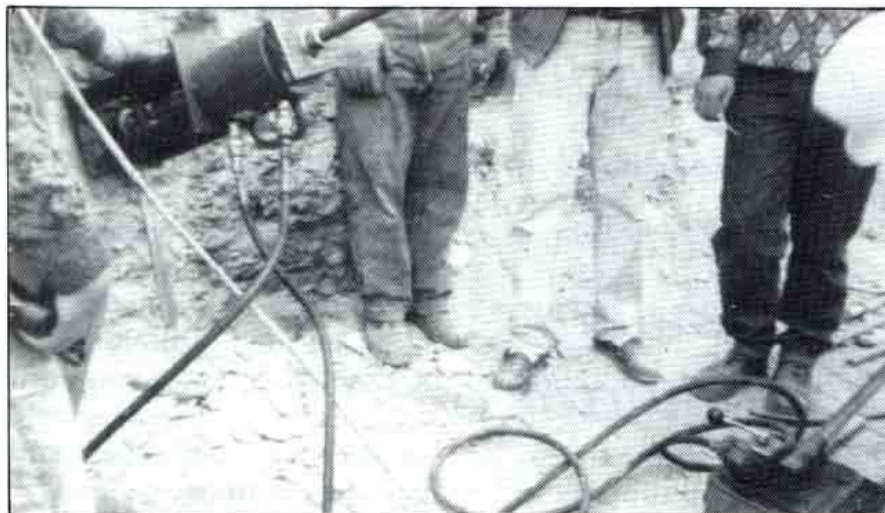
Tesado de anclaje.
