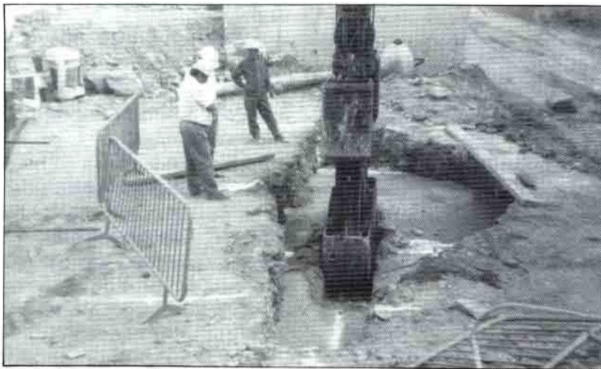
Excavación de batache-pilote en relleno de mortero pobre.
