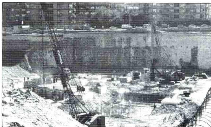
Vista general de la cimentación.
