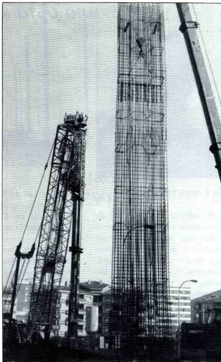
Colocación de armadura de un batache del muro pantalla.
