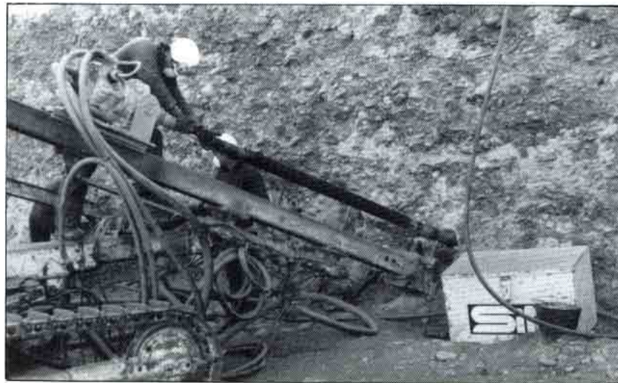
Perforación para anclaje.
