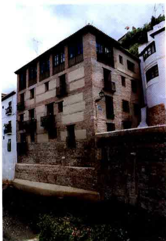
Una vez finalizada la rehabilitación del edificio, se puede apreciar la construcción originaria.
