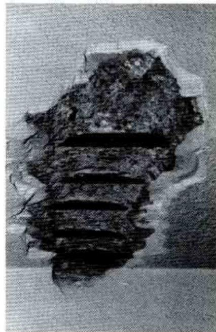
Fig. 10. Detalle de la roza, en momentos positivos, de la figura siguiente donde pueden apreciarse el armado existente, antes de proceder a su macizado).
