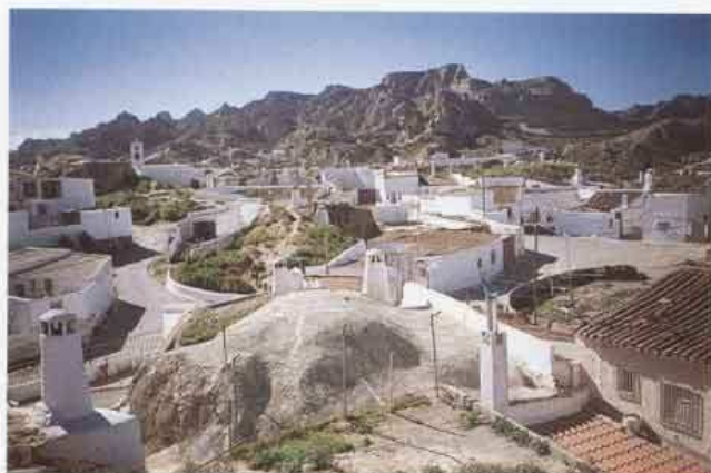
Es normal la colocación de un refuerzo de hormigón exteriormente, que evita el ataque de la corrosión en aquellas cuevas con escaso terreno encima y sin vegetación. (Guadix).
