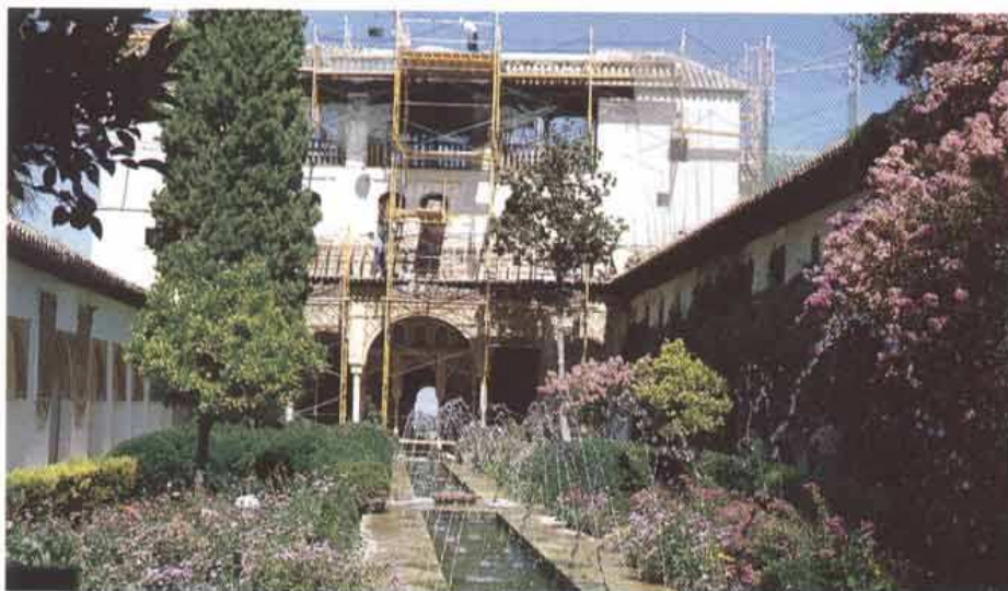
Rehabilitación de un edificio en el Generalife.
