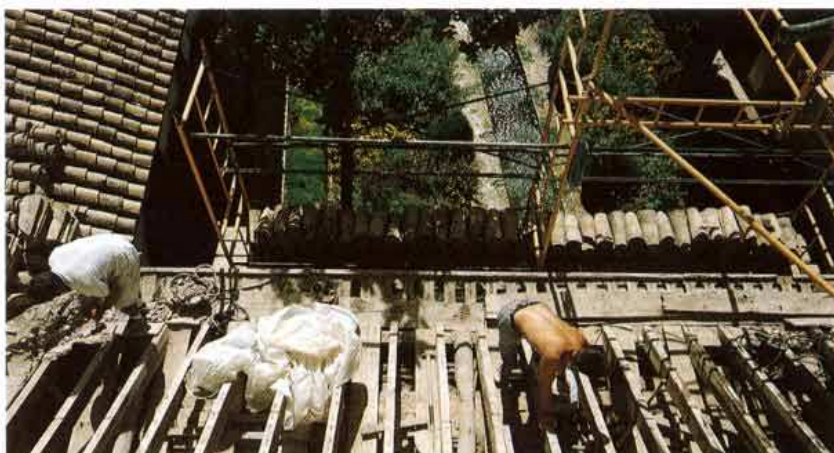
Rehabilitación de una cubierta en el Generalife.
