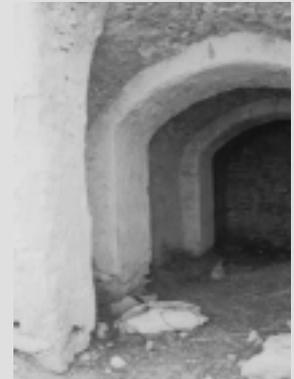
soportan los arcos y que definen la forma de paramentos y bóveda, rebajada en este caso. Dichas pilastras, de 0,50 m. de ancho, quedan aparentes en la planta del habitáculo sobresaliendo 0,30 m., dando un aspecto nuevo al interior del chozón. Tiene un hueco de ventilación-iluminación abierto en el lateral Oeste a una altura de 1,60 m. y con unas dimensiones de 0,25 x
