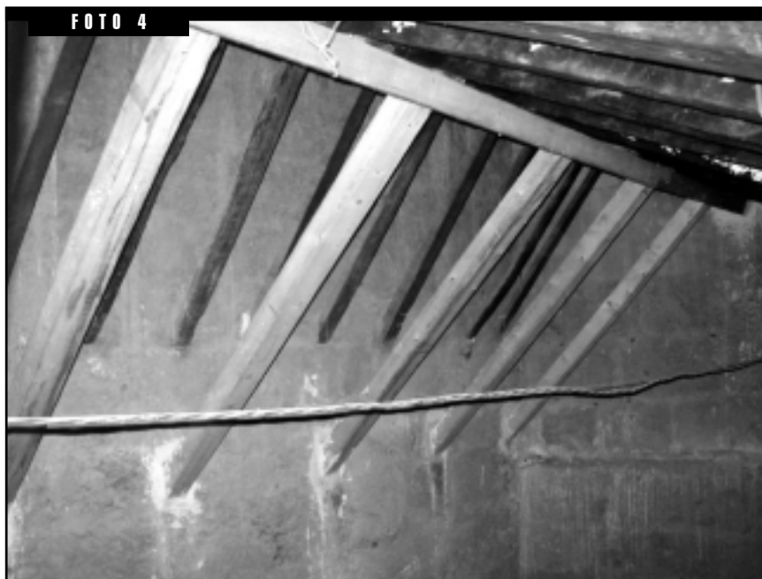
Colocación de durmiente y tornapuntas para corregir la flecha.
