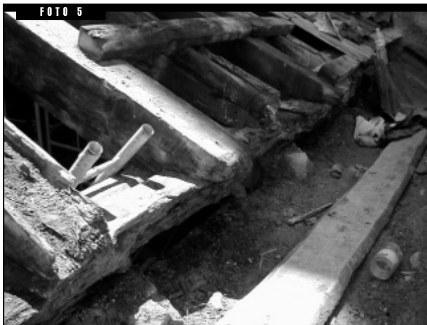
Durmiente y cabezas de pares afectadas de pudrición y ataque de insectos.
