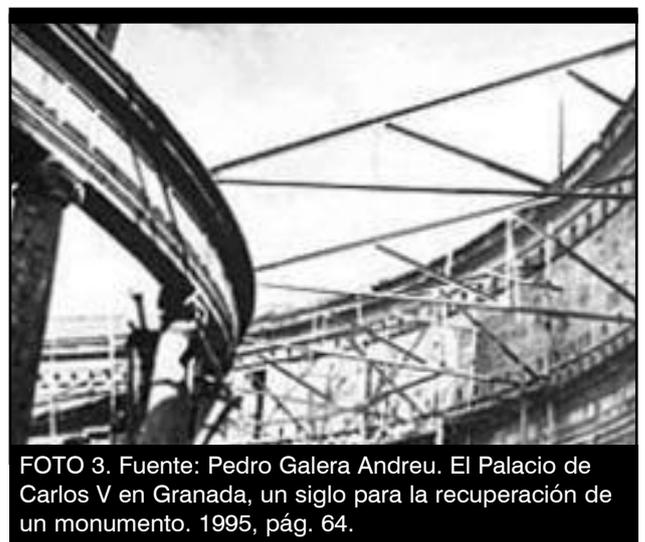
El material de cobertura usado para este faldón es teja árabe, probablemente sobre de chapa desplegable (sin haberse podido confirmar), apoyado mediante celosías metálicas que quedan ocultas por su parte inferior mediante un artesonado de casetones realizado en madera (fotografía 3).
