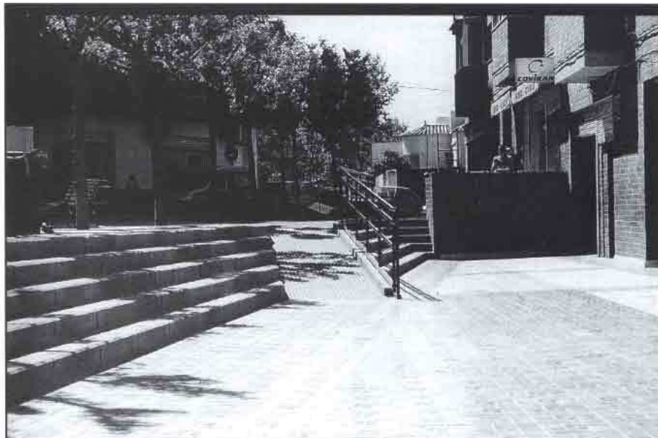
FIGURA 4. En la fotografía se observa una rampa en que su pendiente, su pavimento y su anchura cumplen con la normativa. La rampa posee barandilla en uno de sus dos lados, mientras el otro queda cerrado por la altura de la escalera. Calle Verdiales (Barrio de la Cruz), Granada.
