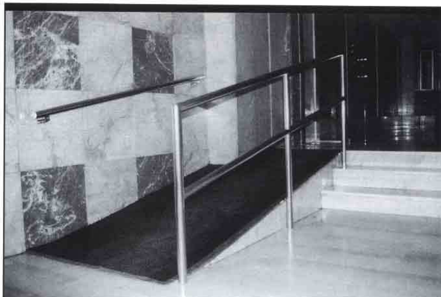
FIGURA 6. La rampa de la figura tiene un pavimento antideslizante de goma. En este caso posee barandilla en ambos lados. Calle Arabial, Granada.
