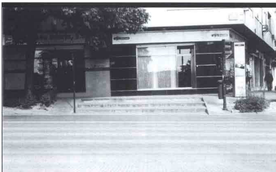
FIGURA 10. La fotografía nos muestra un vado incorrectamente ejecutado, pues el acceso de los minusválidos queda bastante dificultado al tener las escaleras. La alternativa a las mismas, como son las rampas son inviables para los minusválidos, con pendientes excesivamente pronunciadas e incluso se colocan obstáculos en ellas, como el semáforo de la derecha. Avda. Doctor Severo Ochoa, Granada
