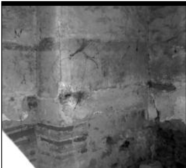
Remate de esquina con ladrillos macizos.
