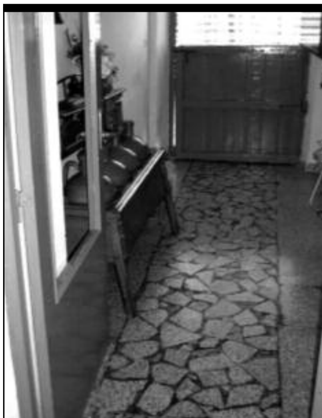
Pavimento de terrazo.
