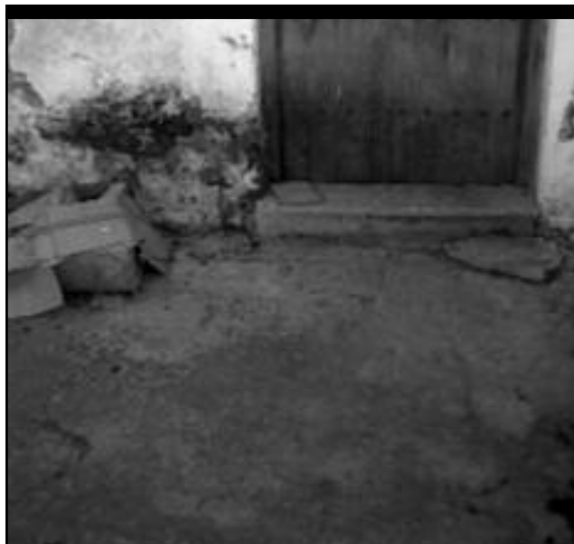
Pavimento continuo de hormigón.
