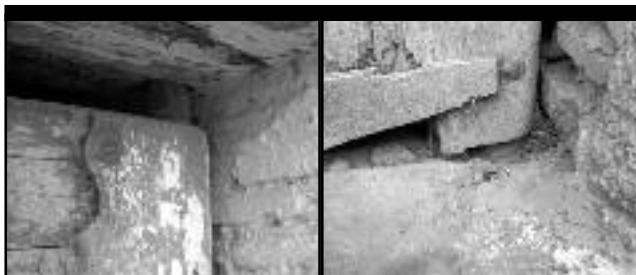
Sistema de anclaje y de giro en el dintel y en el suelo.
