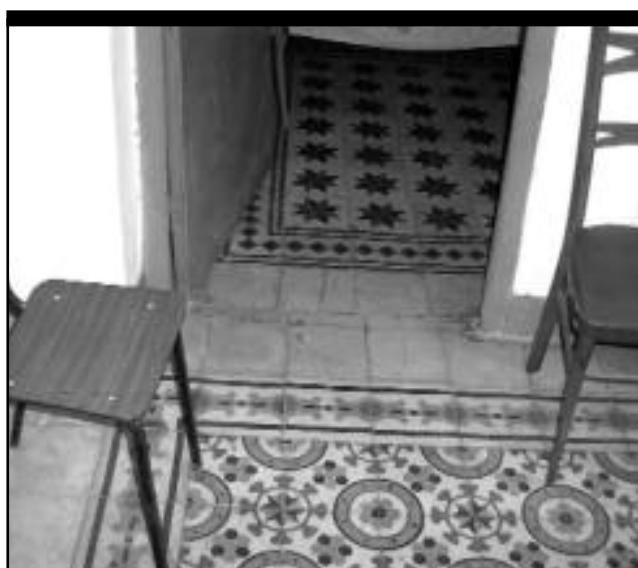
Pavimento de baldosas hidráulicas.
