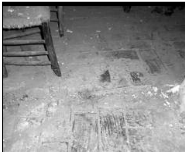
Pavimento de ladrillo.
