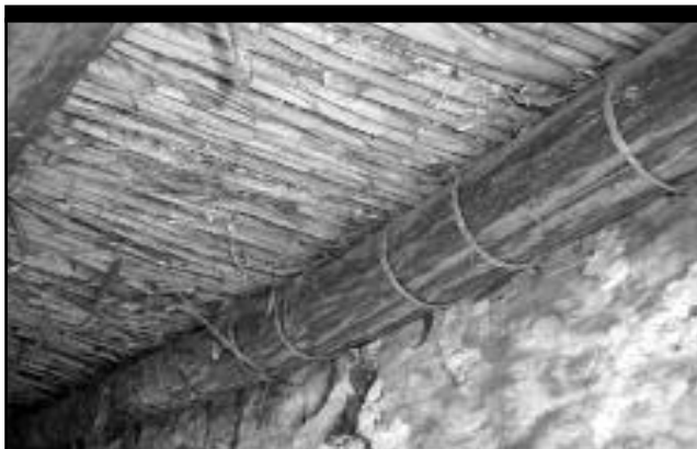
Detalle de atado de las cañas con tomizas a la viga.
