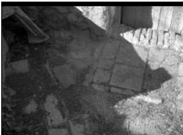
Pavimento de tierra, de baldosas de cerámica y de ladrillo macizo.
