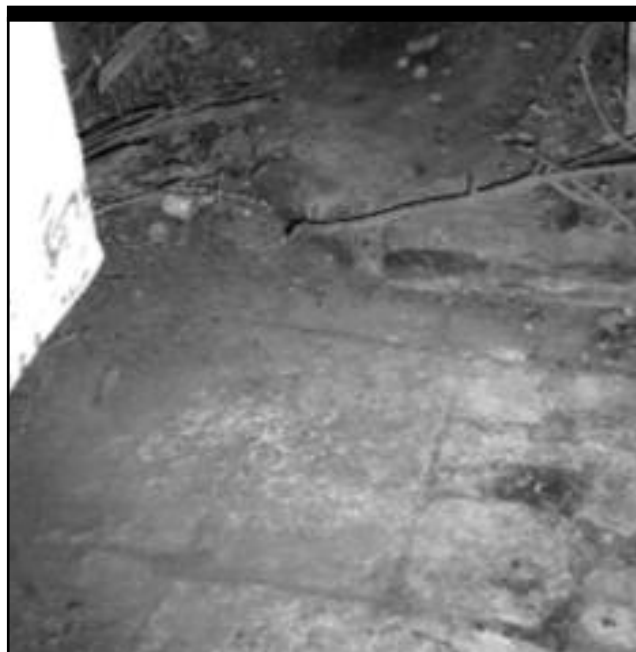
Pavimento de baldosas cerámicas de 'barro'
