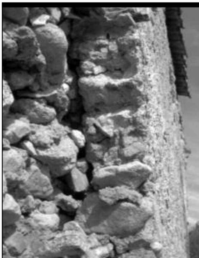
Seccionado de un muro de carga a base de mampuestos.
