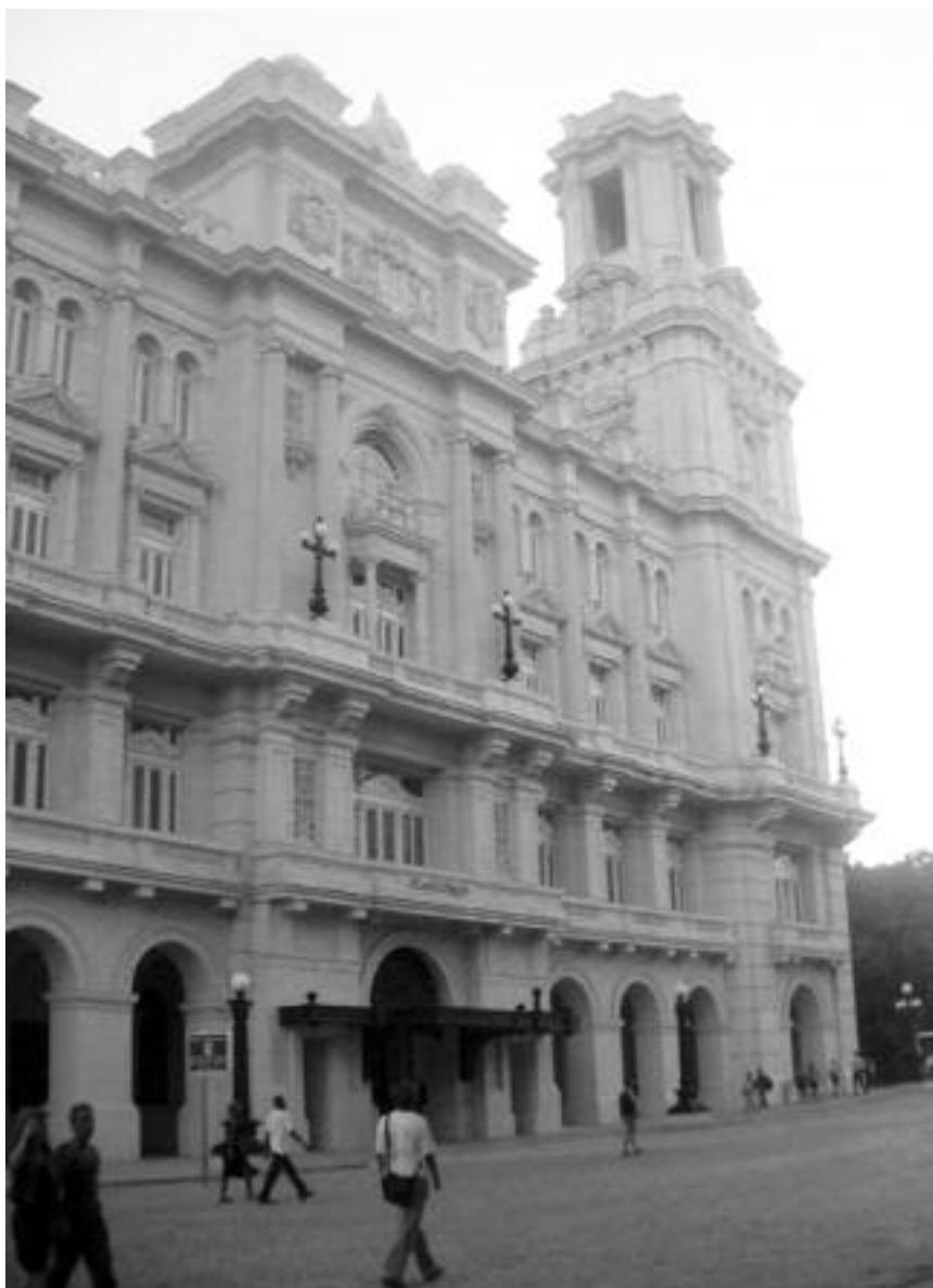
Edificio Asturiano después de su restauración.
