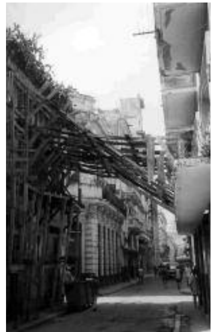
Apuntalamiento en una edificación de la calle Teniente Rey.
