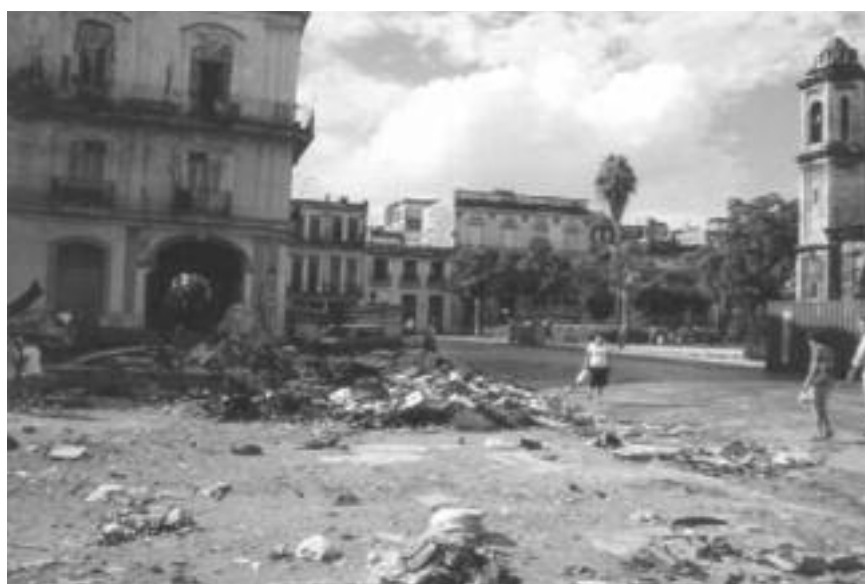
Restos de una demolición en las proximidades de la Plaza del Cristo.
