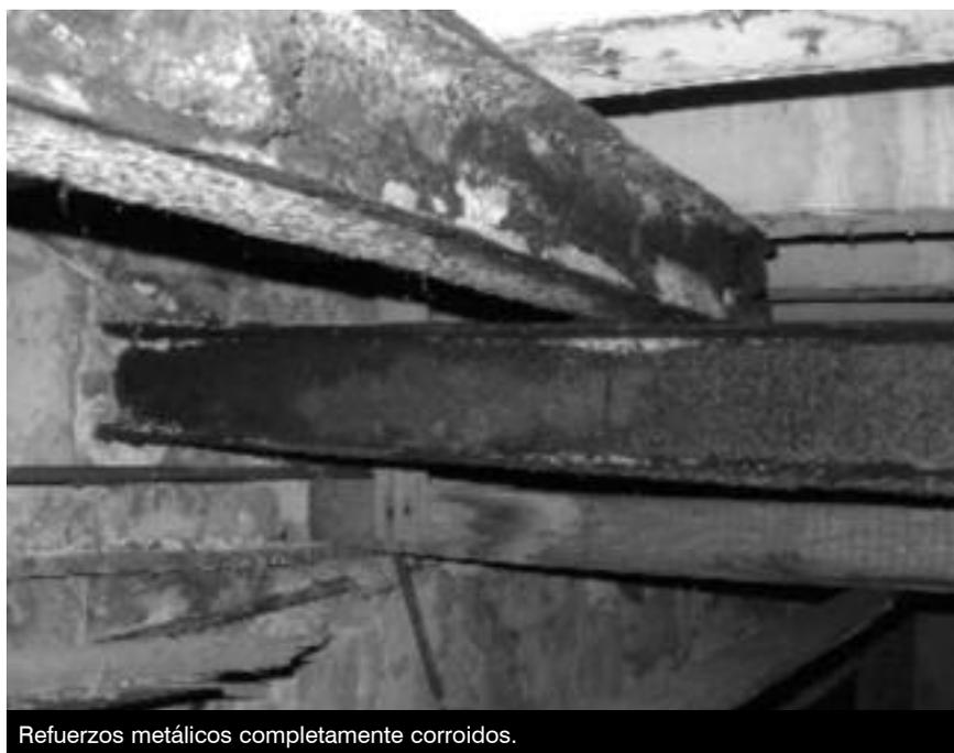
Refuerzos metálicos completamente corroidos.
