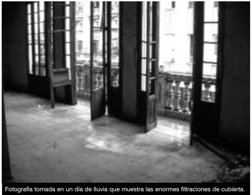
Fotografía tomada en un día de lluvia que muestra las enormes filtraciones de cubierta.
