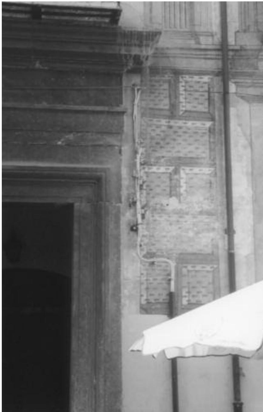
La generación de yeso produce un aumento volumen, formando costras sulfatadas, e indirectamente provocando descamaciones y desplazados.
