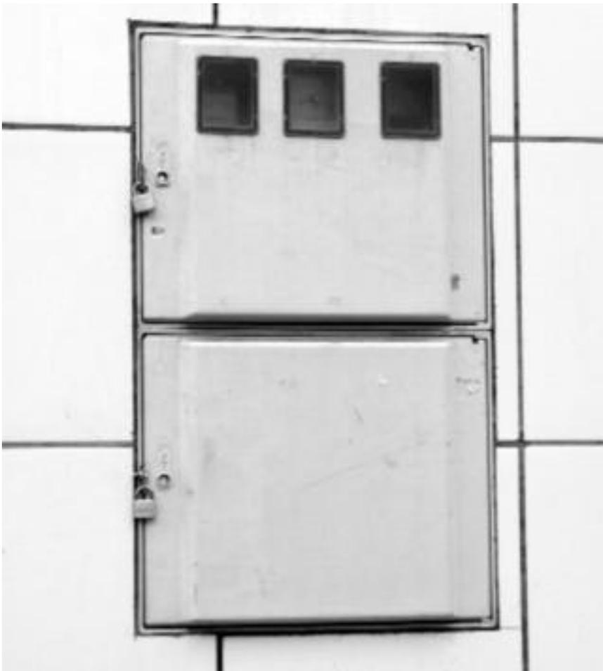
Caja general de protección, con módulo exterior colocado en fachada para sistema de medida con ventanilla de fácil lectura.
