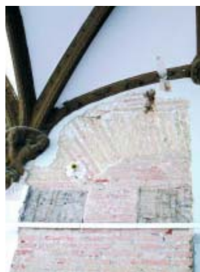
Catas realizadas en muros y revestimientos.
