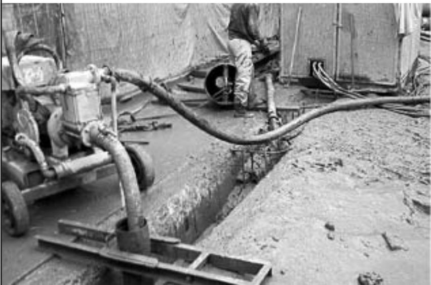
Introducción de tubo para hormigonar la pantalla.
