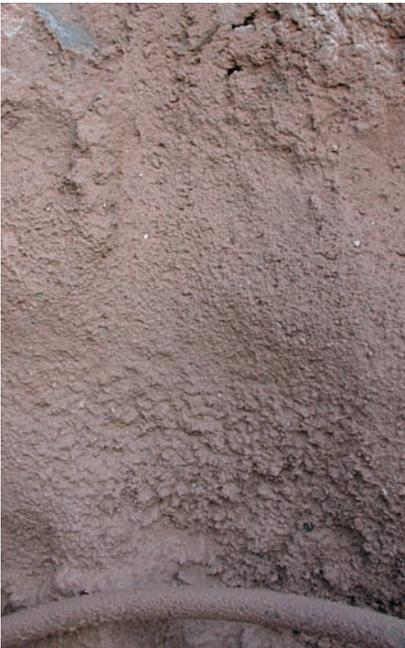
»» **Con la vía seca resulta difícil de controlar la salida simultánea de la mezcla de material y del agua originándose segregaciones siendo de destacar una importante pérdida de aglomerantes.**
